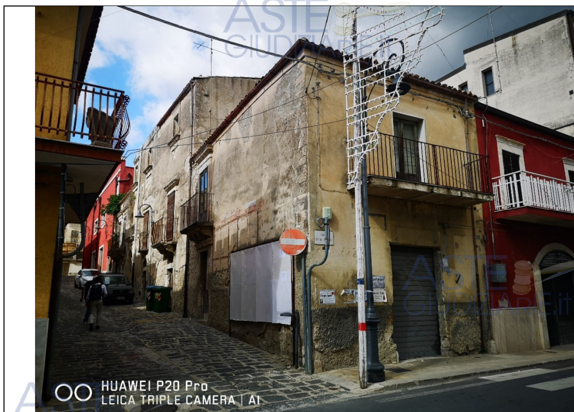
Foto n.2 Prospetto Corso XX settembre
