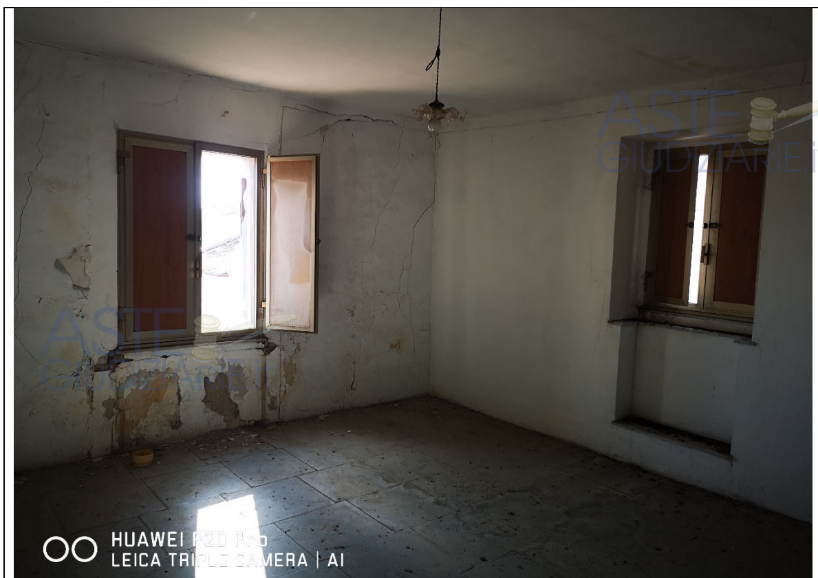
Foto n.12: Sgombero piano Secondo
