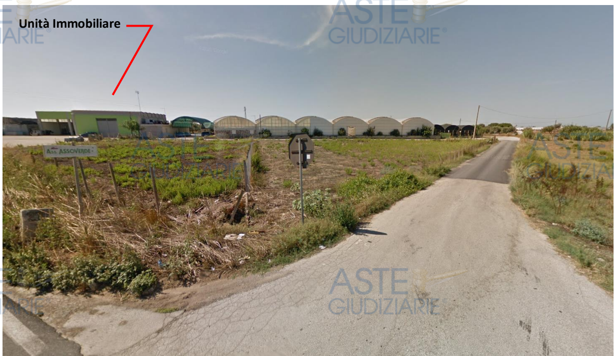
Foto n. 1.01 : Ingresso dalla Strada Statale n°115 "Sud Occidentale Sicula".
