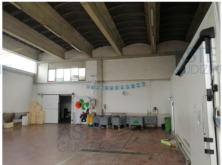
Foto n. 1.12 : Fabbricato A - Magazzino
