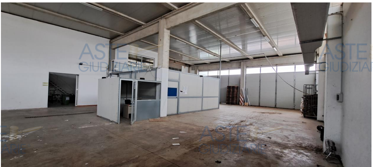
Foto n. 1.35 : Fabbricato B – Magazzino A (Foto anno 2024)
