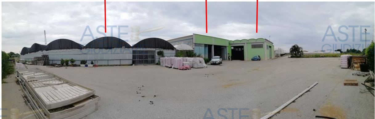
Foto n. 1.06 : Particella 626 (ex 523) – fabbricati con antistante piazzale.
