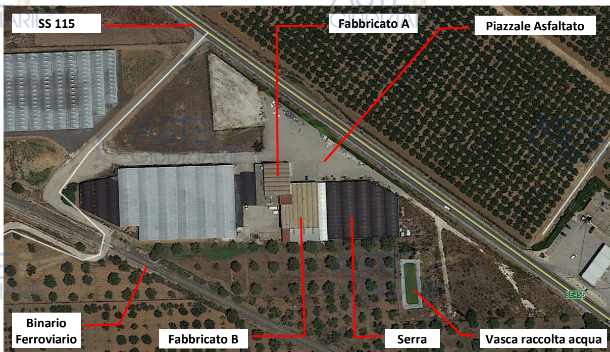
Figura n. 1.8 : Foto satellitare dell'unità immobiliare oggetto di stima
