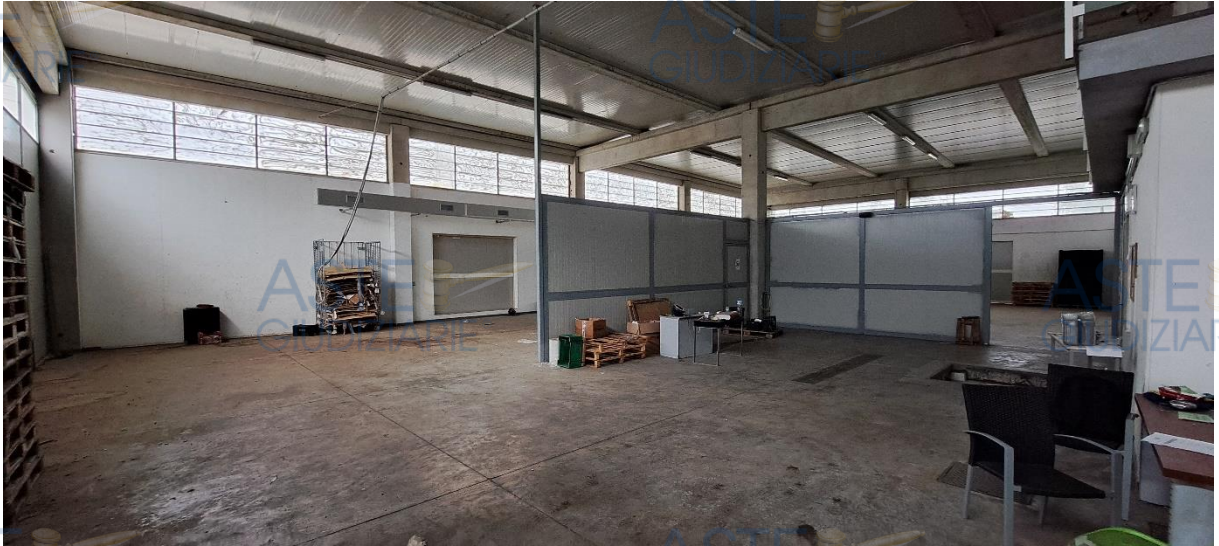
Foto n. 1.32 : Fabbricato B – Magazzino A (Foto anno 2024)
