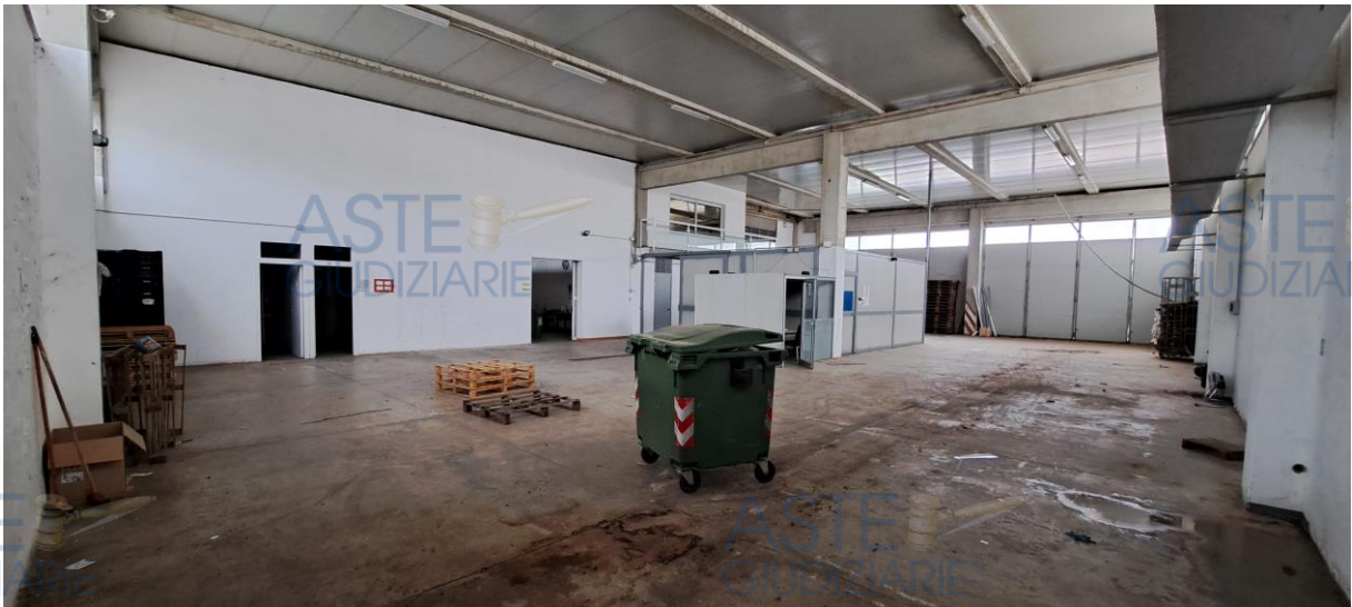
Foto n. 1.37 : Fabbricato B – Magazzino B (Foto anno 2024)
