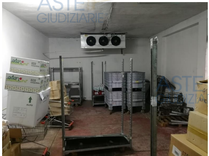
Foto n. 1.21 : Fabbricato A – Cella Frigo 2
