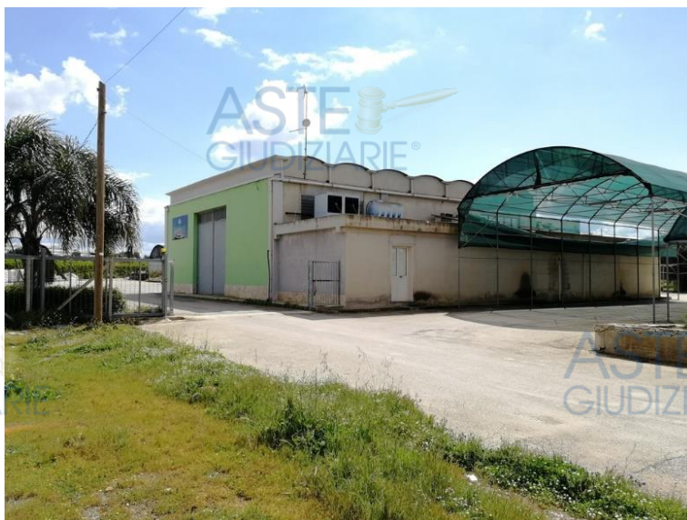
Foto n. 1.04 : Ingresso ai fabbricati
