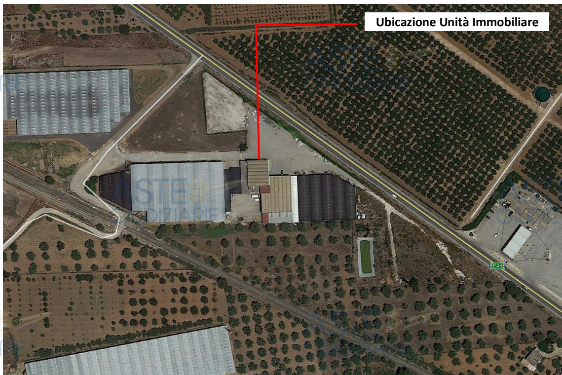
Figura n. 1.4 : Foto satellitare dell'unità immobiliare oggetto di stima
