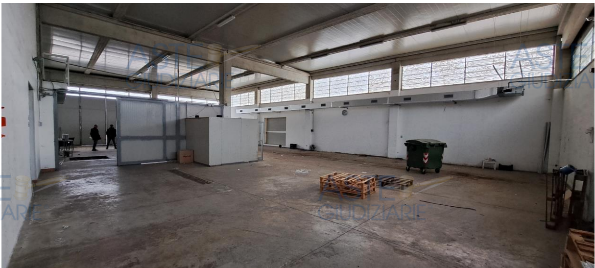
Foto n. 1.38 : Fabbricato B – Magazzino B (Foto anno 2024)
