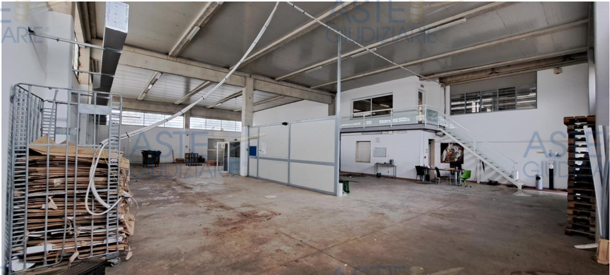
Foto n. 1.36 : Fabbricato B – Magazzino B (Foto anno 2024)
