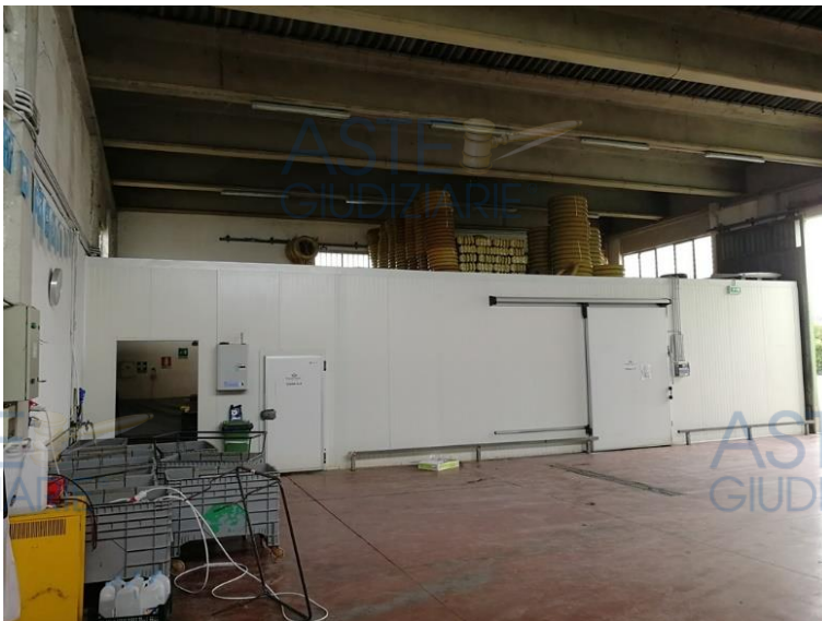
Foto n. 1.15 : Fabbricato A - Magazzino
