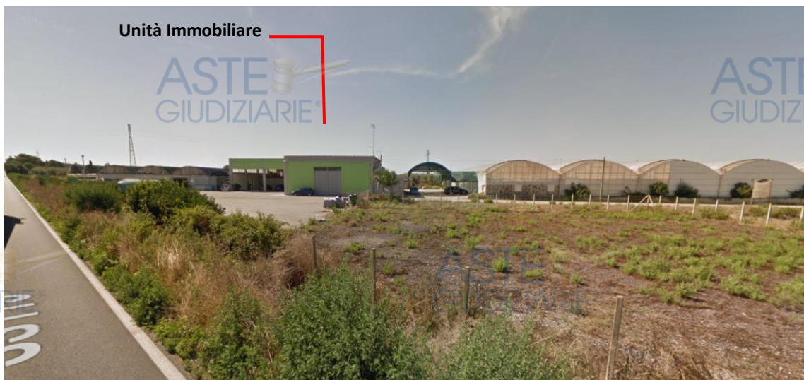
Figura n. 1.7 : Foto dell'unità immobiliare oggetto di stima - vista SS 115 direzione Gela - Vittoria
