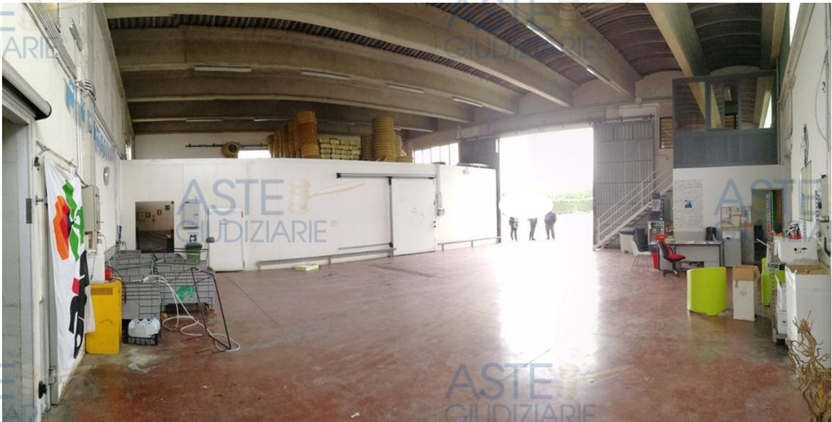
Foto n. 1.14 : Fabbricato A – Magazzino
