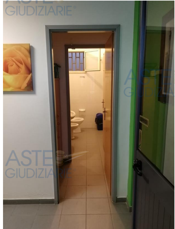
Foto n. 1.25: Fabbricato A – Anti Bagno
