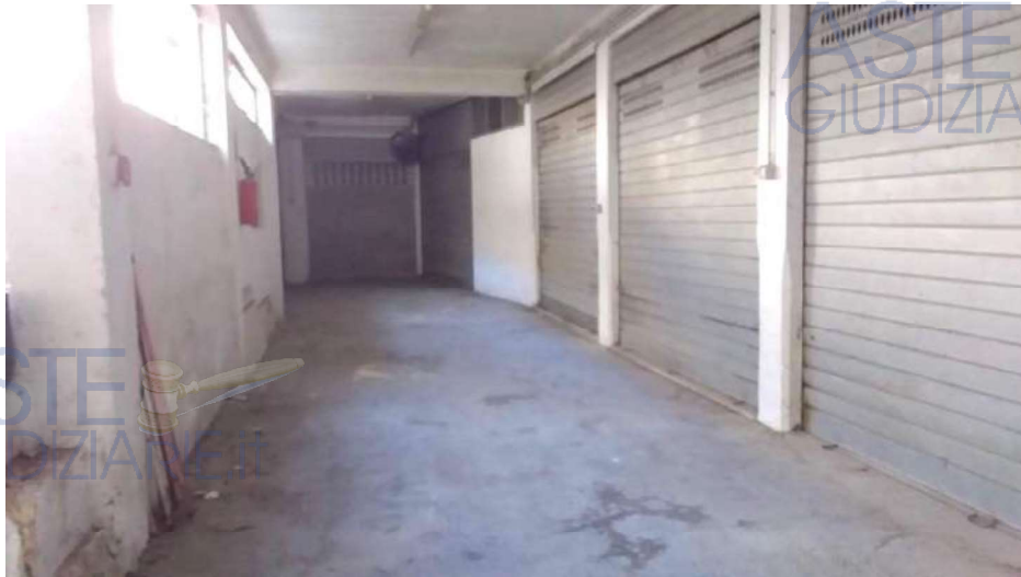
Foto 14 Lotto 2 Garage cat. C6 piano sotterraneo particelle 121 sub 10-11-12-13 Ragusa Foglio 50
