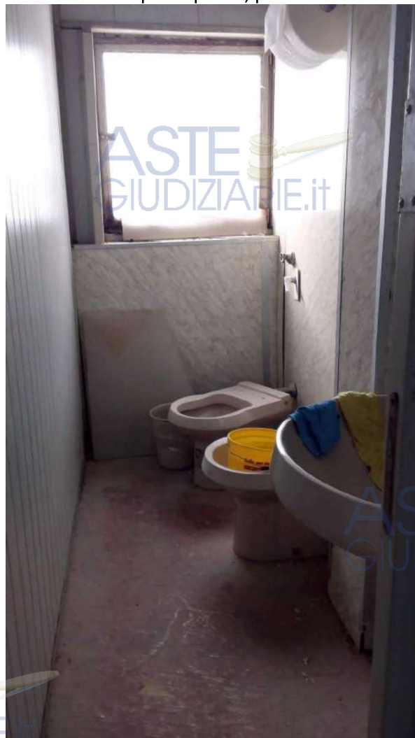
Foto 66 Lotto 2 Bagno uffici cat. A10 piano primo, particella 121 sub 24 Ragusa Foglio 50
