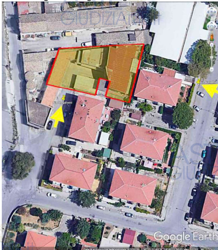
Figura 4 Lotto 2 Foto aerea Fabbricato Ragusa 50 particella 121
