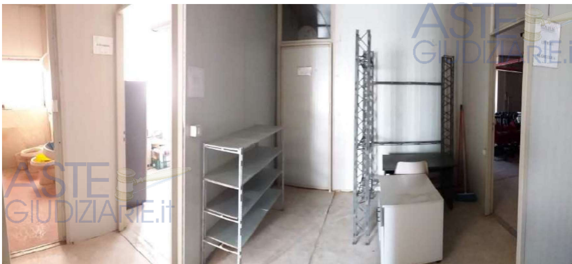
Foto 50 Lotto 2 Interno uffici cat. A10 piano primo, particella 121 sub 24 Ragusa Foglio 50
