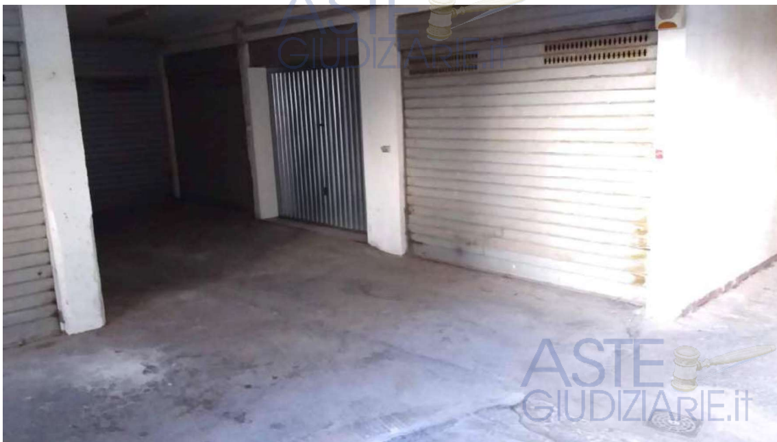
Foto 11 Lotto 2 Garage cat. C6 piano sotterraneo particelle 121 sub 6-7-8-9 Ragusa Foglio 50
