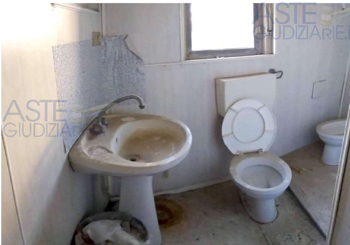
Foto 56 Lotto 2 Bagno uffici cat. A10 piano primo, particella 121 sub 24 Ragusa Foglio 50
