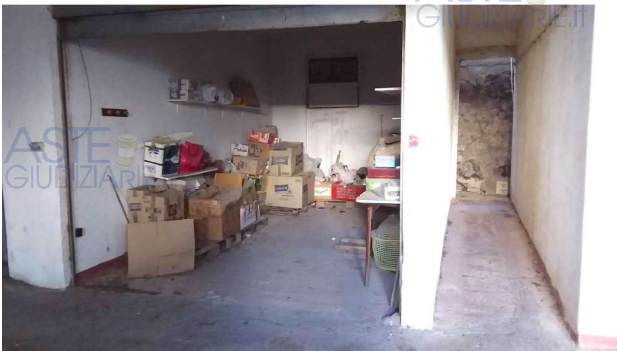
Foto 22 Lotto 2 Interno garage cat. C6 piano sotterraneo particella 121 sub 6 Ragusa Foglio 50
