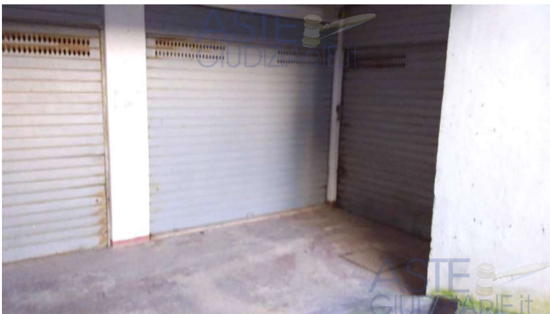
Foto 9 Lotto 2 Garage cat. C6 piano sotterraneo particelle 121 sub 3-4-5 Ragusa Foglio 50
