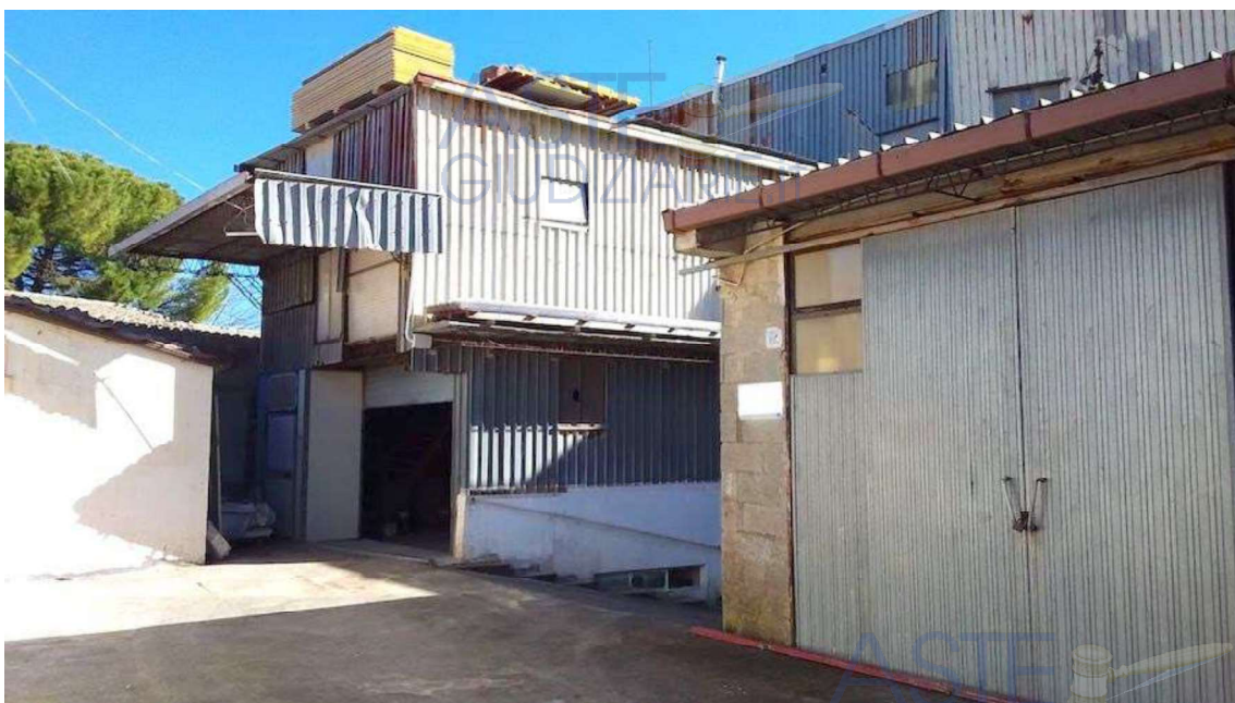
Foto 2 Lotto 2 Fabbricato piano terra particella 121 dalla Via Ungaretti Ragusa Foglio 50
