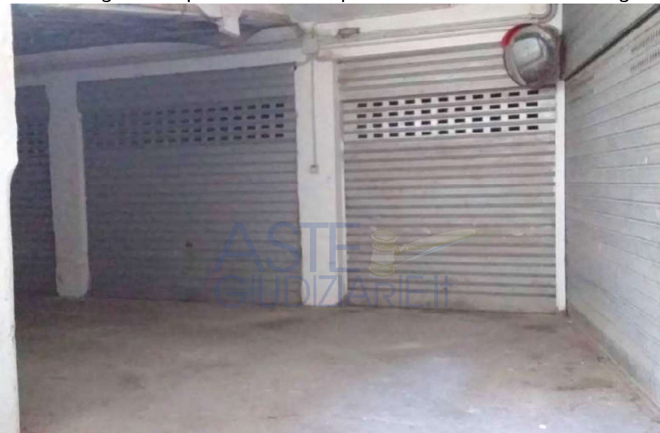
Foto 15 Lotto 2 Garage cat. C6 piano sotterraneo particelle 121 sub 13-14-15 Ragusa Foglio 50
