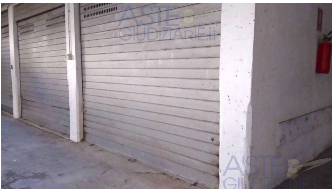
Foto 13 Lotto 2 Garage cat. C6 piano sotterraneo particelle 121 sub 10-11 Ragusa Foglio 50
