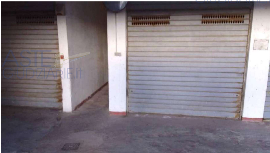
Foto 10 Lotto 2 Garage cat. C6 piano sotterraneo particelle 121 sub 5-6 Ragusa Foglio 50
