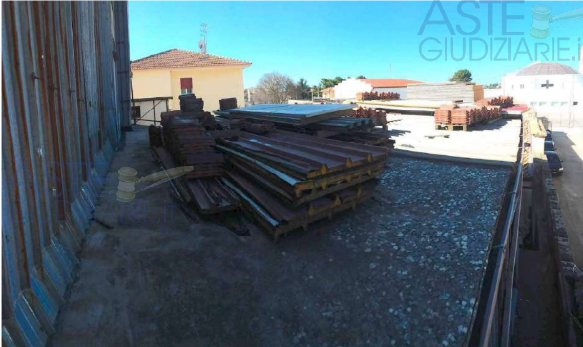
Foto 74 Lotto 2 Terrazza annessa all'unità in corso di costruzione F3 a piano secondo, particella 121 sub 25 Ragusa Foglio 50
