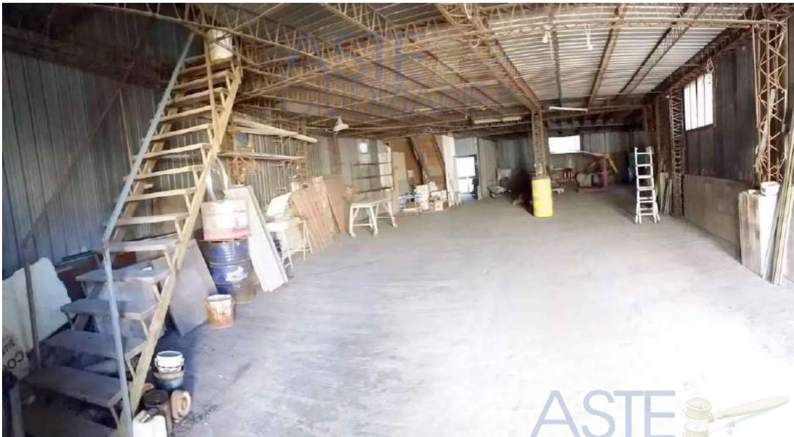
Foto 31 Lotto 2 Laboratorio cat. C3 a piano terra, particella 121 sub 2 Ragusa Foglio 50, dalla Via Ungaretti, con vano scala sub 26 per accesso a piano primo.
