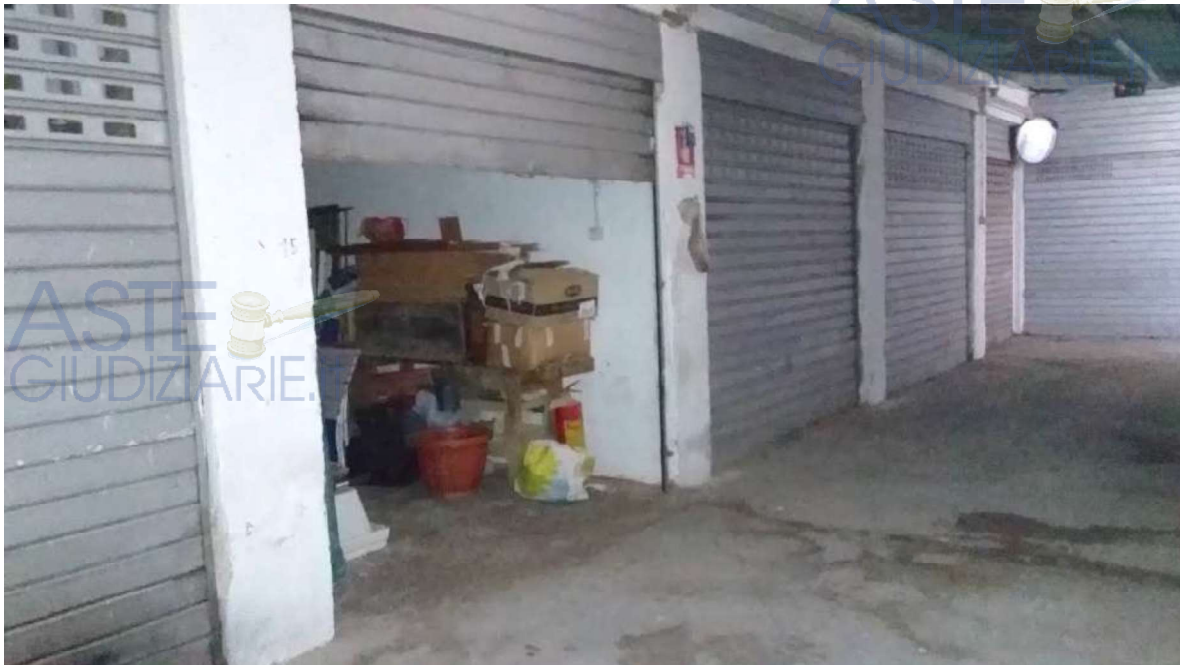
Foto 28 Lotto 2 Interno garage cat. C6 piano sotterraneo particella 121 sub 17 Ragusa Foglio 50
