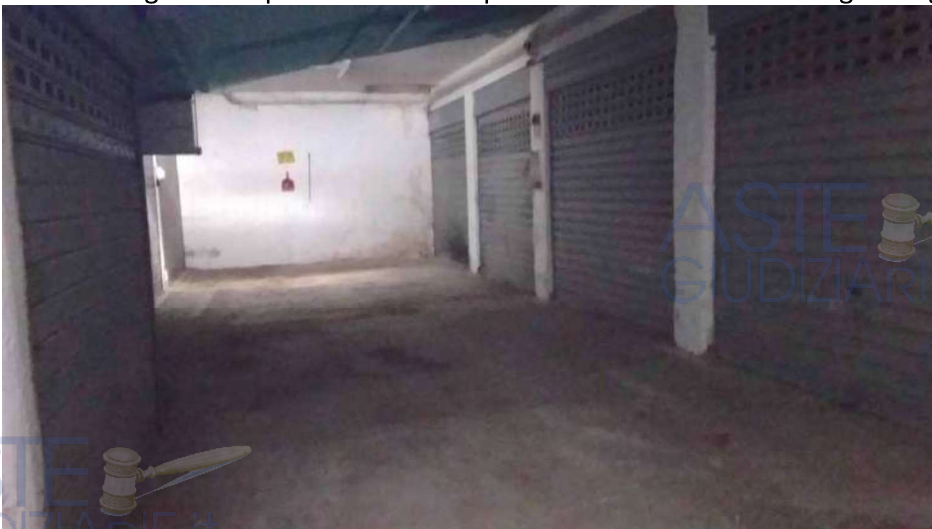
Foto 16 Lotto 2 Garage cat. C6 piano sotterraneo particelle 121 sub 15-16-17-18-22 Ragusa Foglio 50
