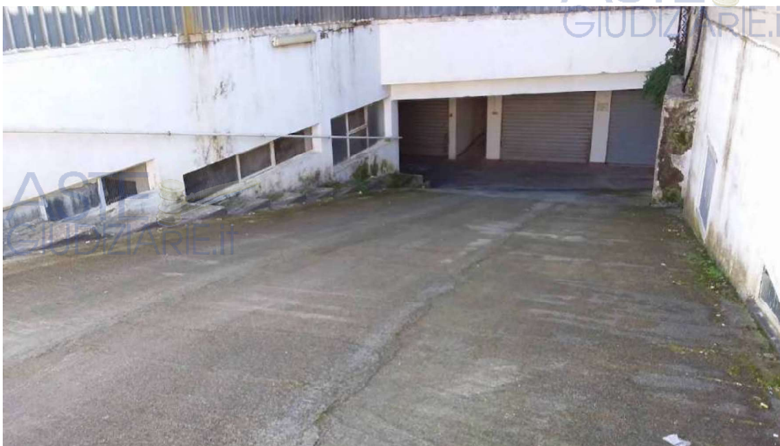
Foto 8 Lotto 2 Accesso ai garage al piano sotterraneo particelle 121 dal sub 3 al sub 22 Ragusa Foglio 50
