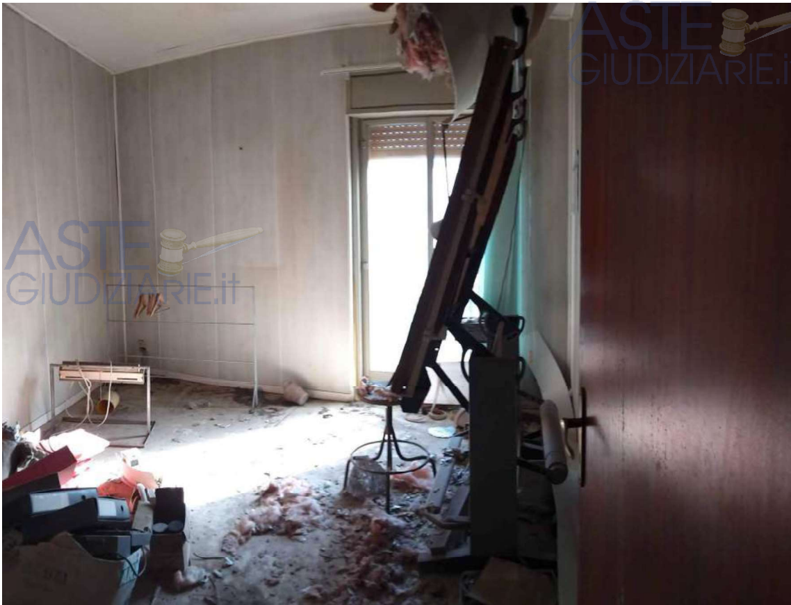
Foto 54 Lotto 2 Interno uffici cat. A10 piano primo, particella 121 sub 24 Ragusa Foglio 50
