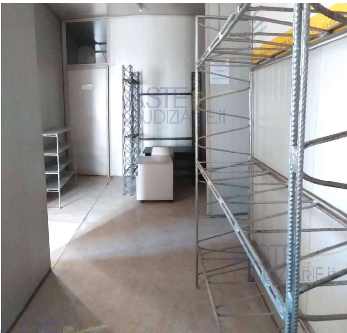
Foto 51 Lotto 2 Interno uffici cat. A10 piano primo, particella 121 sub 24 Ragusa Foglio 50
