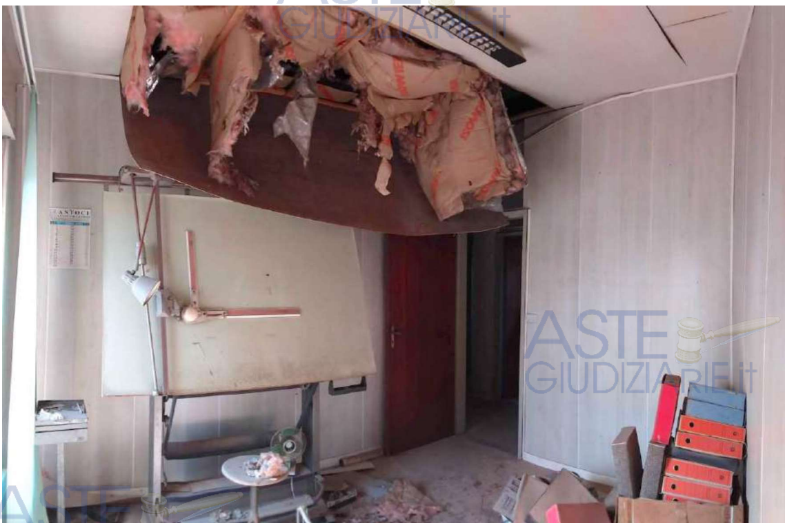
Foto 55 Lotto 2 Interno uffici cat. A10 piano primo, particella 121 sub 24 Ragusa Foglio 50
