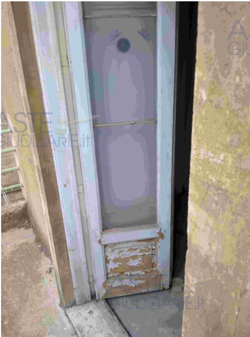
Foto n. 18 – Infissi esterni in legno e vetro.
