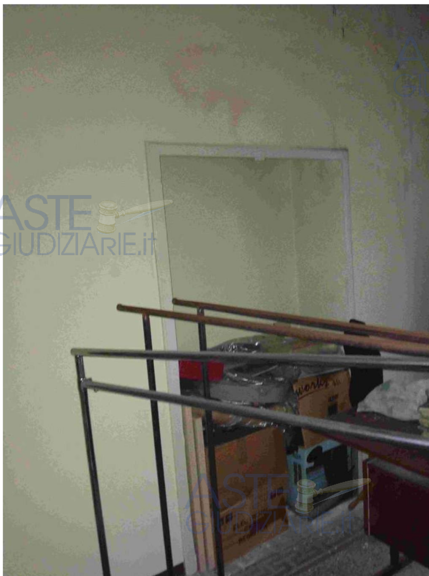
Foto n. 13 – attrezzature presenti camera n. 2.
