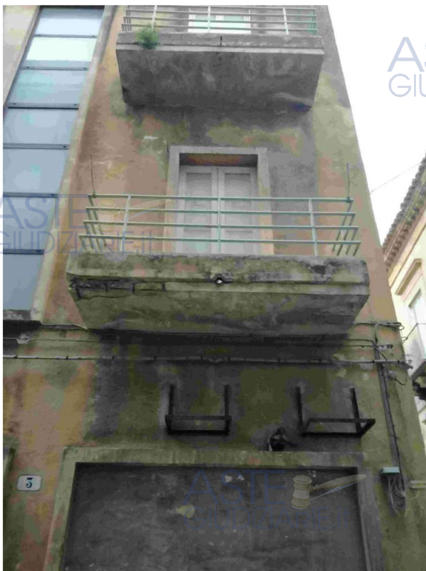
Foto n. 3 – Appartamento al primo piano, lato via Xiumè.
