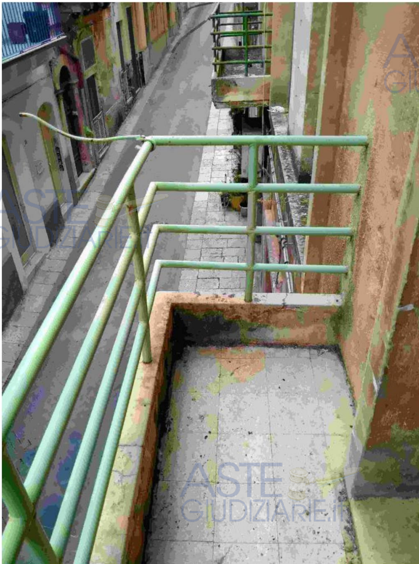
Foto n. 20 – balcone sulla via Xiumè.
