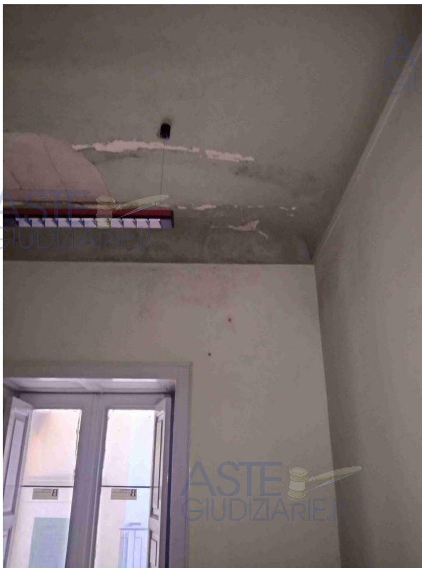
Foto n. 14 – Infiltrazioni acqua 1.
