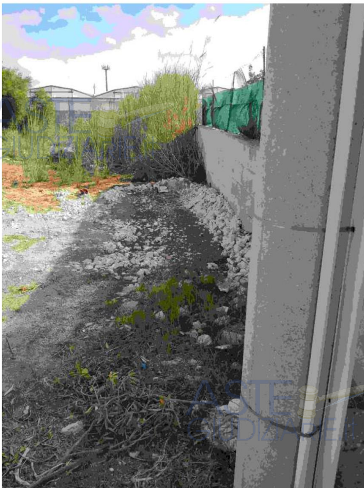
Foto n. 25 – Delimitazione terreno con muro in blocchi di cemento.
