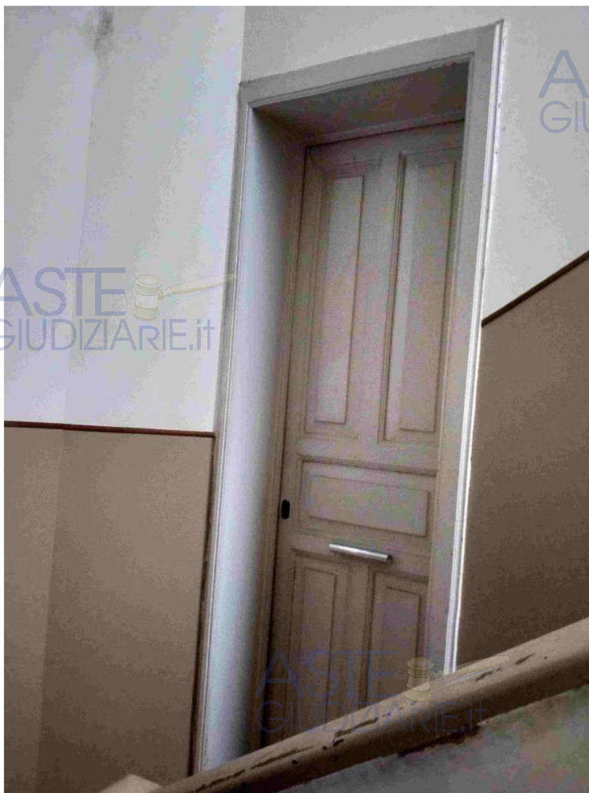
Foto n. 17 – Seconda porta di ingresso in legno.
