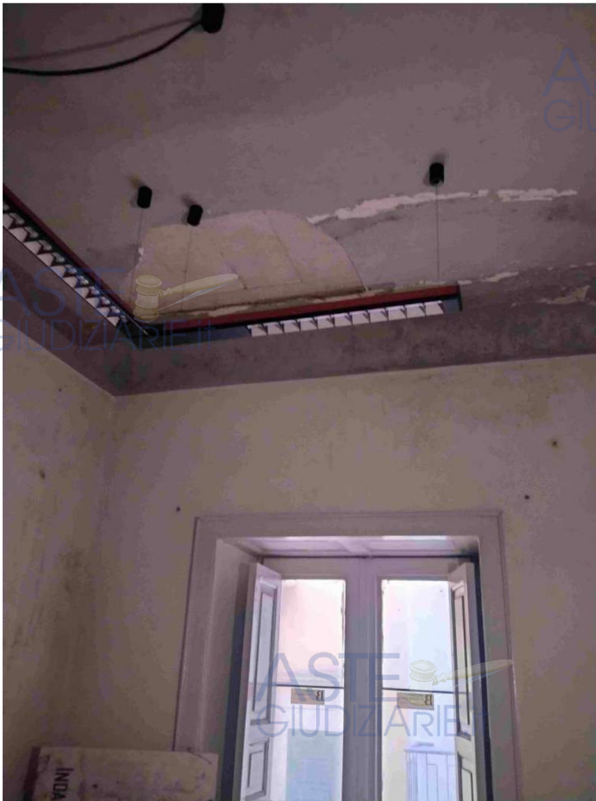
Foto n. 15 – Infiltrazioni acqua 2.
