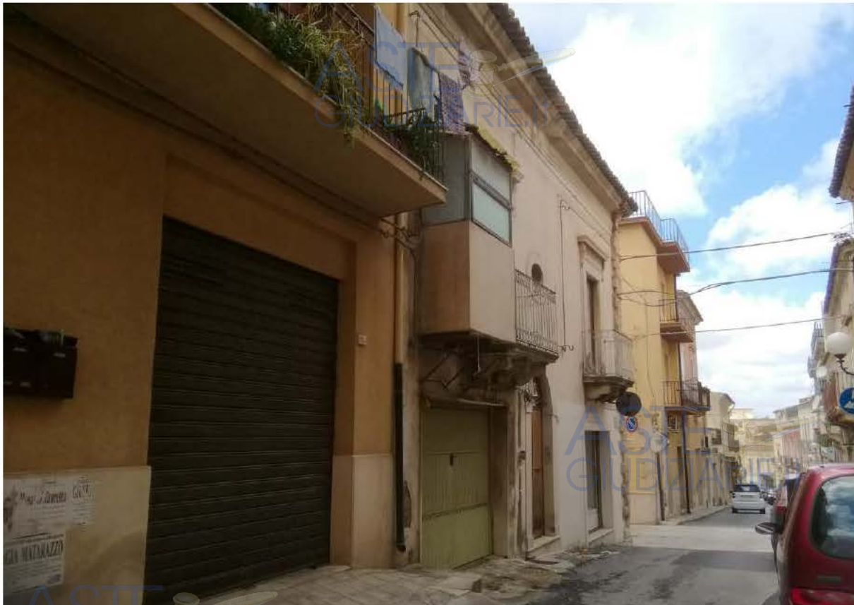
Foto 01. Prospetto via Pace con ingresso vano scala e garage
