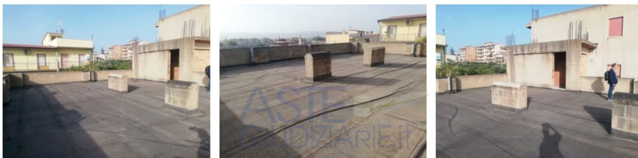
Vista del bene 7 lastrico solare (riproduzione completa in All.03g).
