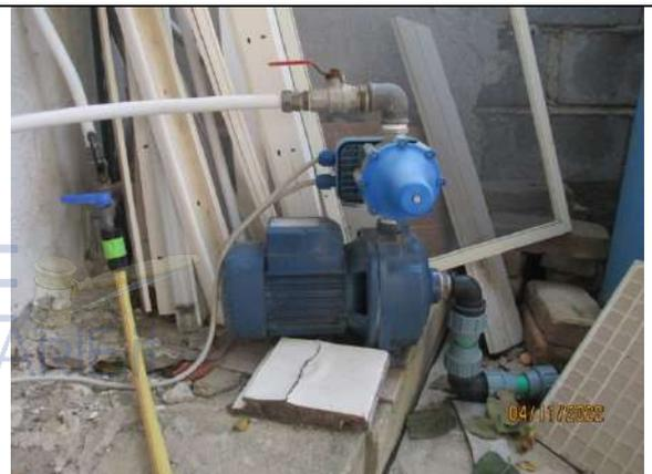
Foto 14. Particolare del motore dell'impianto autoclave
