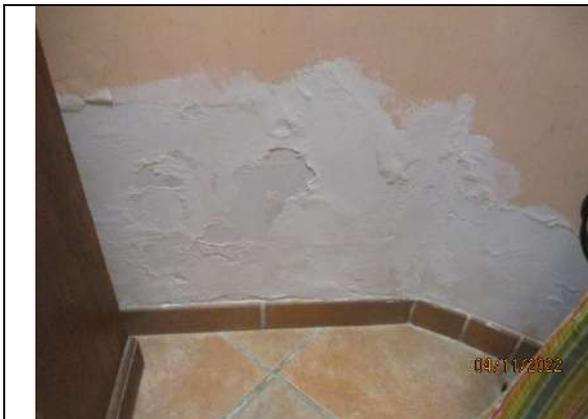
**Foto 34.** Particolare delle tracce di umidità di risalita presenti sulle pareti, in corrispondenza del pavimento
