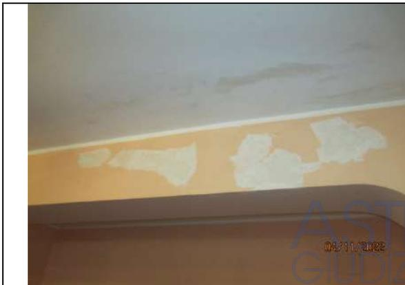
**Foto 32.** Particolare delle tracce di umidità presenti sul soffitto del soggiorno/pranzo
