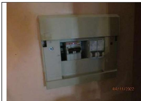
**Foto 10.** Particolare del quadro generale dell'impianto elettrico dell'appartamento
