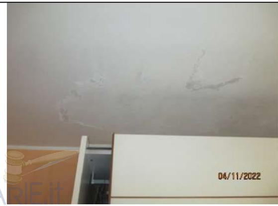
**Foto 33.** Particolare delle tracce di umidità presenti sul soffitto della camera da letto
