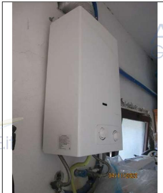
**Foto 17.** Vista del presente scaldino a gas per l'acqua calda sanitaria
