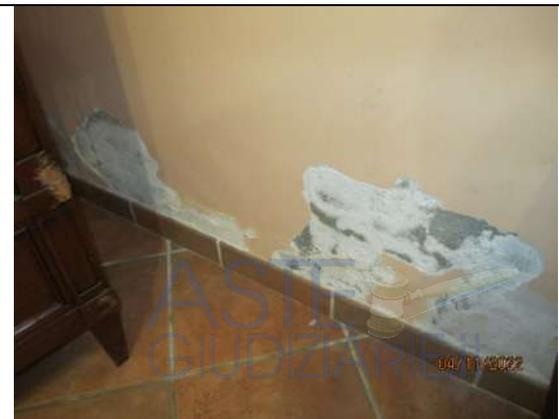
**Foto 35.** Particolare delle tracce di umidità di risalita presenti sulle pareti, in corrispondenza del pavimento
