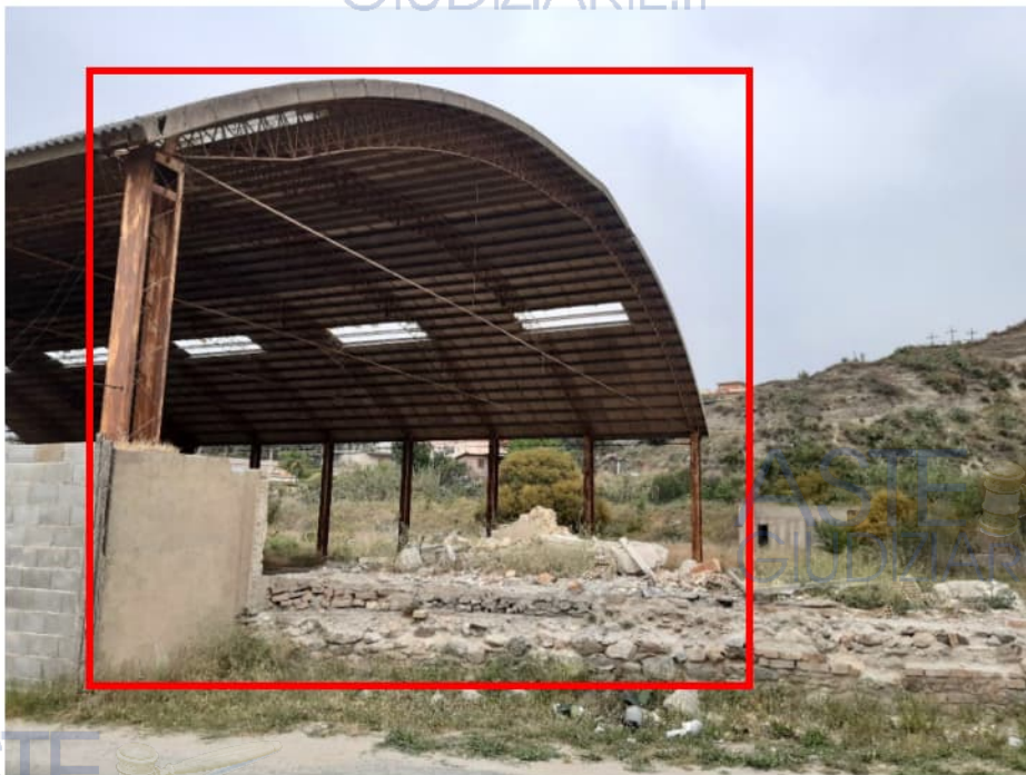
Figura 12: Confine prospetto Sud-Est
