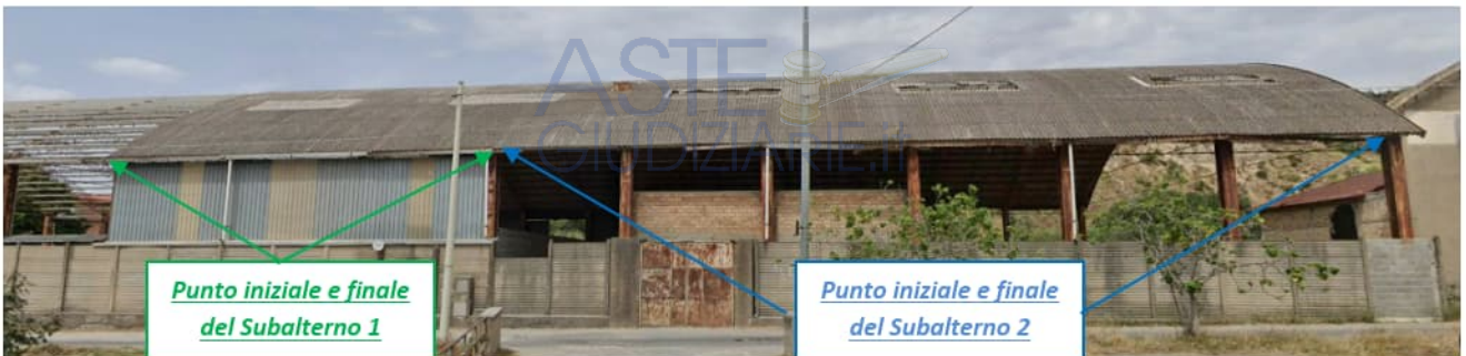
Figura 6: Vista esterna (lato strada) dei subalterni 1 e 2
