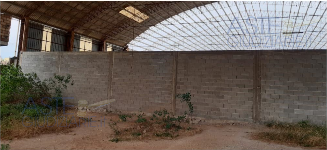
Figura 8: Parete divisoria tra subalterno 1 e subalterno 2
