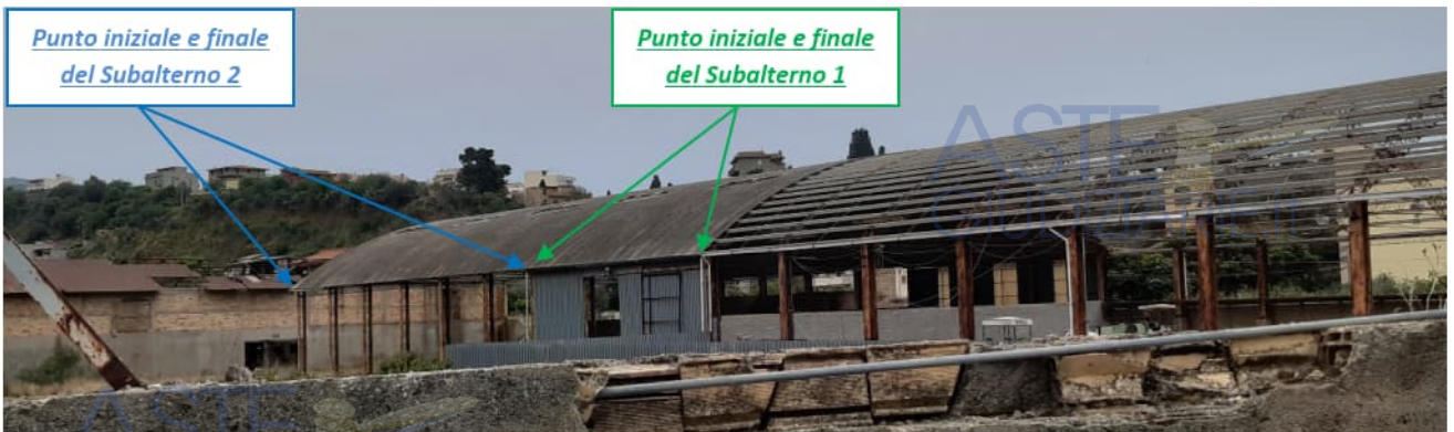
Figura 7: Vista interna (lato Particella 752) dei subalterni 1 e 2
