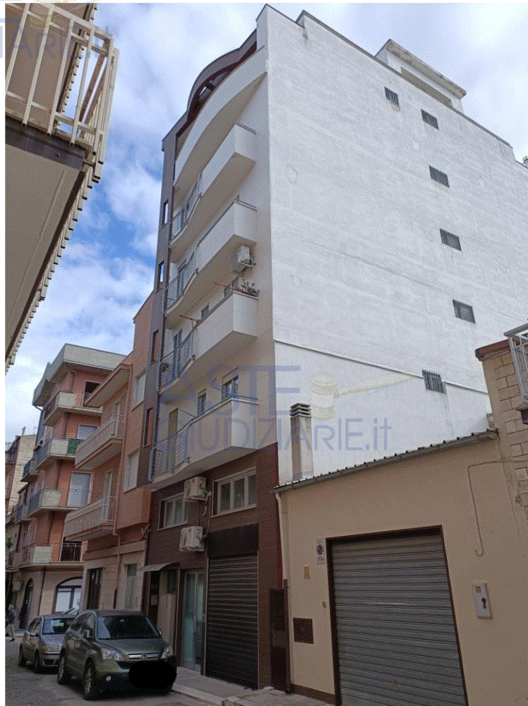
Figura 1 – Panoramica Condominio Via Micaeli, n. 43, Lavello (PZ).
