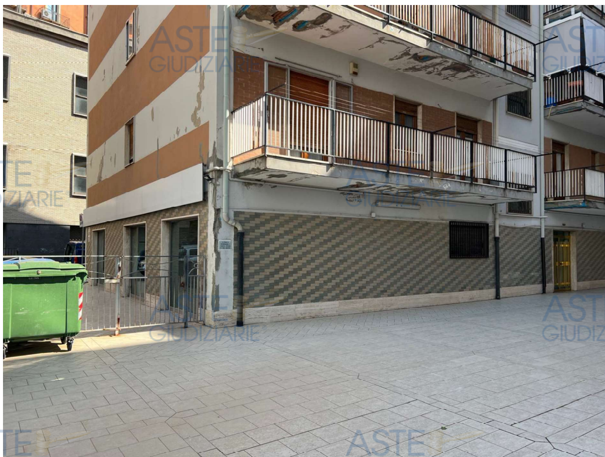
Figura 2 – Panoramica Prospetto Posteriore Locale Commerciale, Corso Garibaldi, n. 28, Potenza (PZ).
