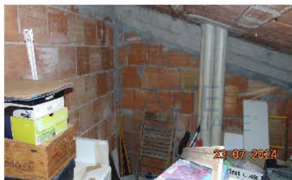
Interno soffitta (parete H= 2.10)
