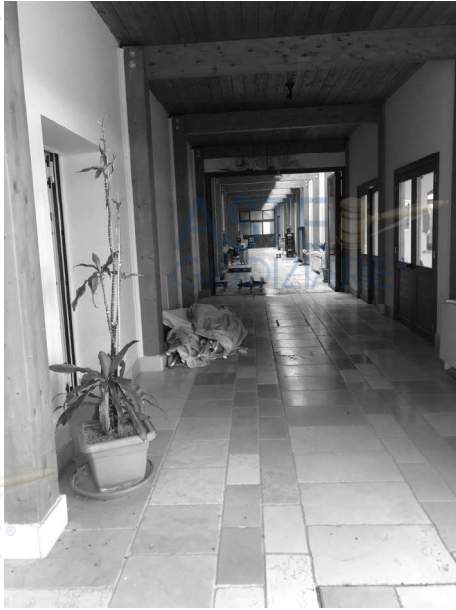
Sistema Connettivo Tratto "B"
