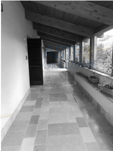
Sistema Connettivo Tratto "B"
