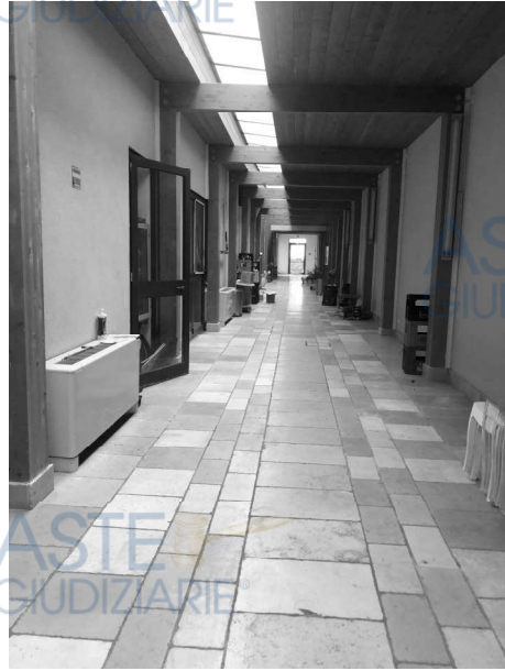
Sistema Connettivo Tratto "B"
