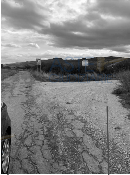
SP 10 – strada privata in massiciata di stabilizzato
