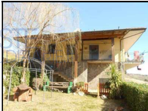
Prospetto Ingresso Fabbricato
