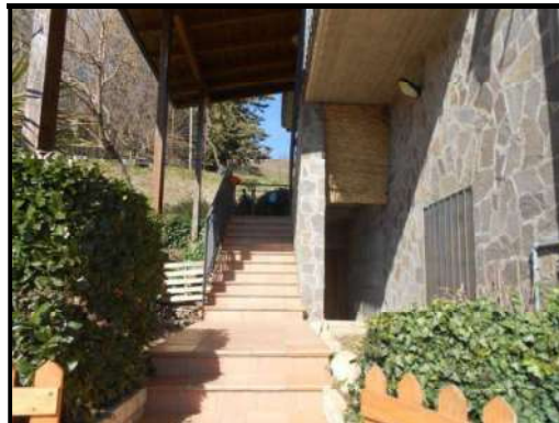
Scala accesso Piano 1° - Abitazione
