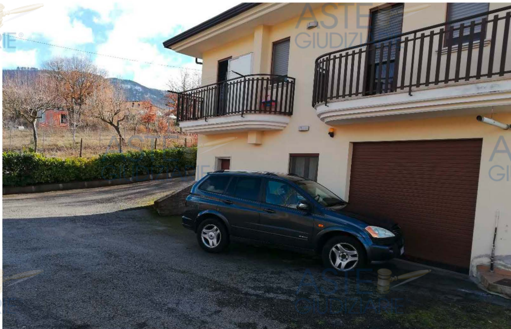
5. Veduta del prospetto posteriore dell'immobile
