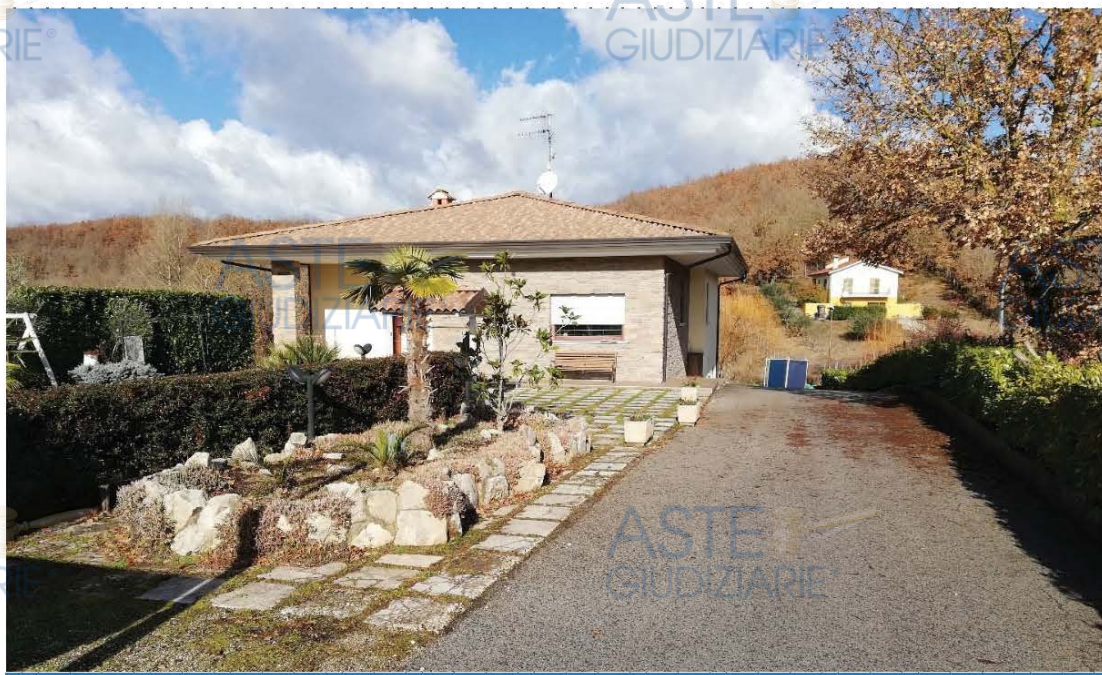
1. Veduta del prospetto anteriore dell'immobile dalla strada privata di accesso al lotto
