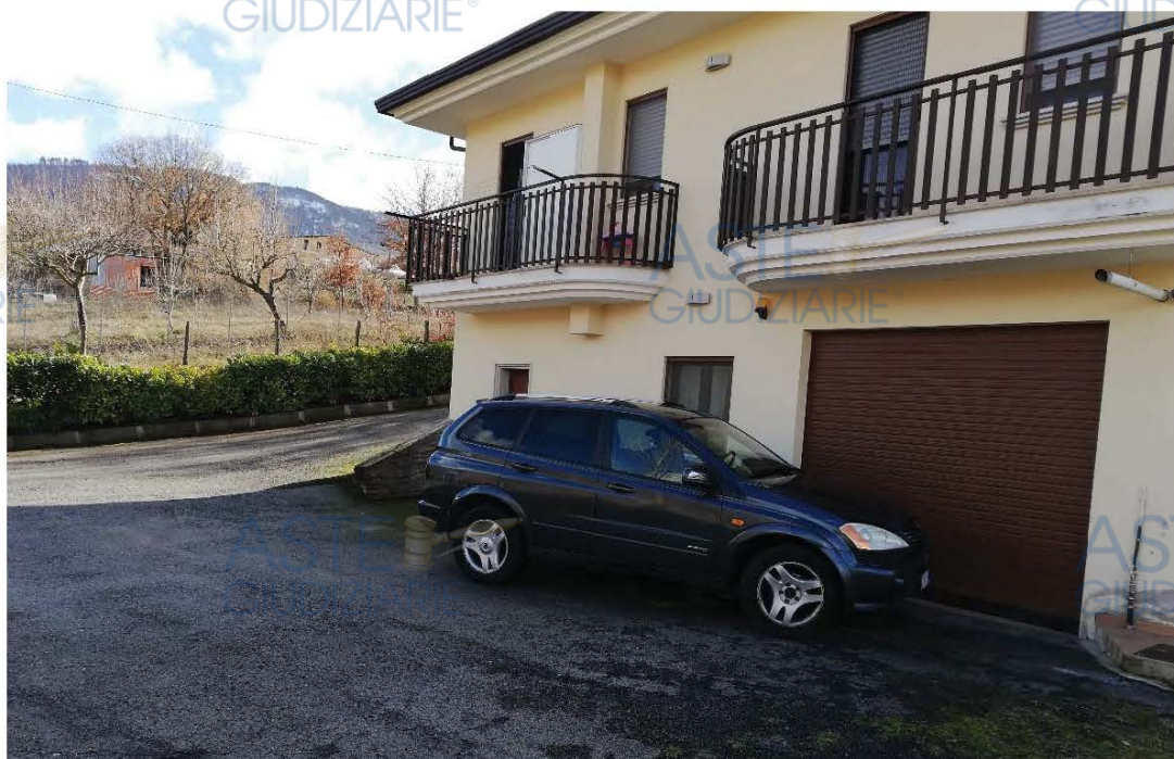
2. Veduta del prospetto posteriore dell'immobile
