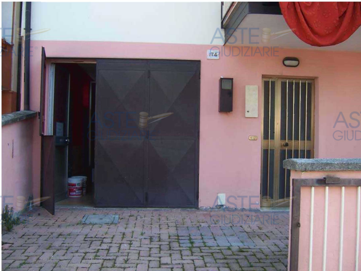
Ingresso esterno locale garage ufficio
