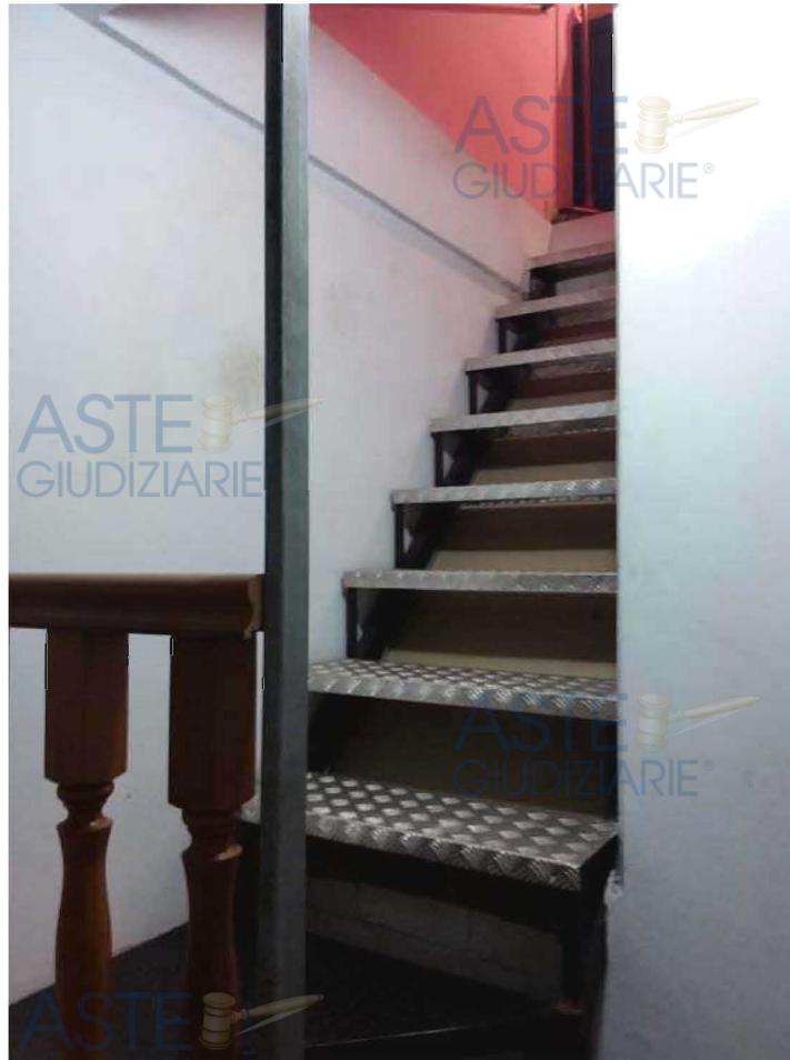
Scala interna tra piano terra e garage ufficio al piano interrato
