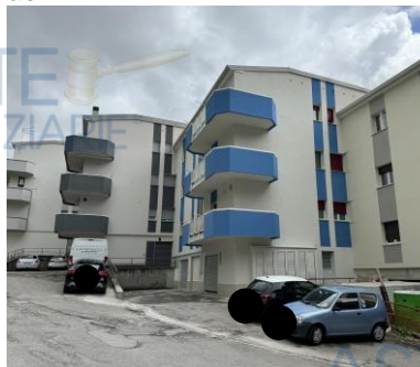
FOTO 8 – Vista d'angolo lato Nord.
