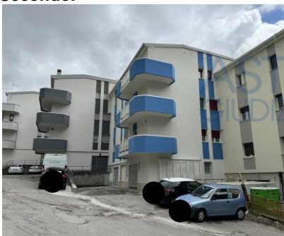
FOTO 17 – Vista d'angolo lato Nord.
