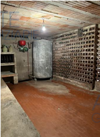
FOTO 22 – Cantina al Piano S1.
