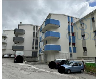
FOTO 26 – Vista d'angolo lato Nord.
