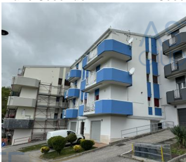
FOTO 7 – Vista d'angolo lato a Sud.
