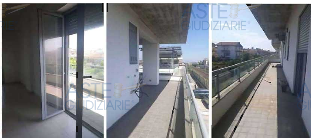
Livello primo – Interni uffici / Servizi igienici, particolari infissi, balcone e loggia
