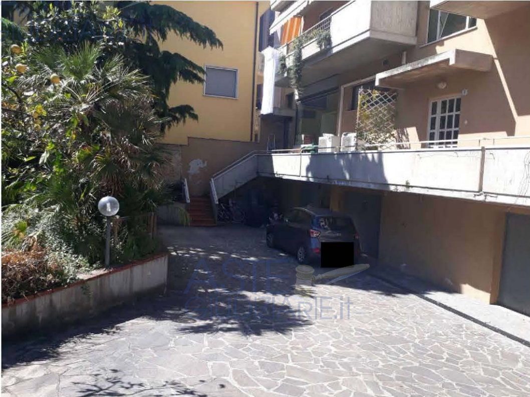
Viste della corte condominiale
