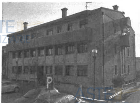
Prospetto nord del Condominio
