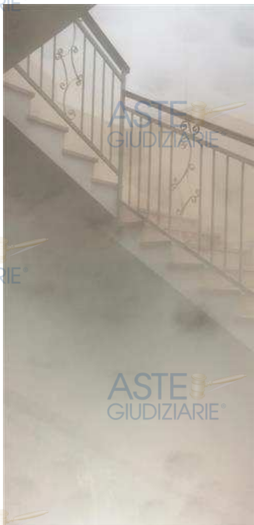
Vano scala interno di accesso ai piani
