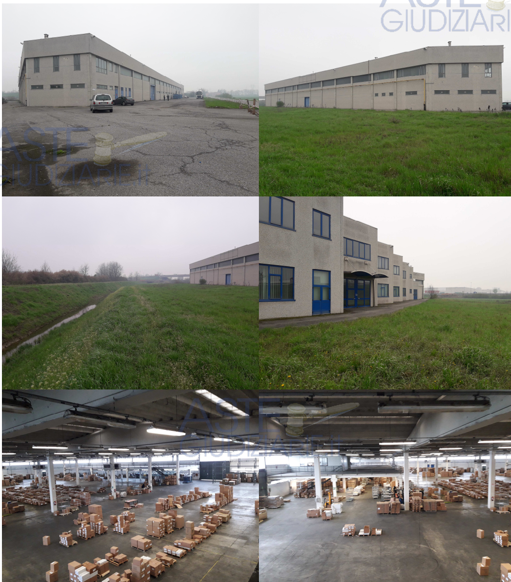
Figg. 1-4: vedute esterne del fabbricato di cui al punto A Figg. 5-6: vedute interne del fabbricato di cui al punto A: zona produttiva
