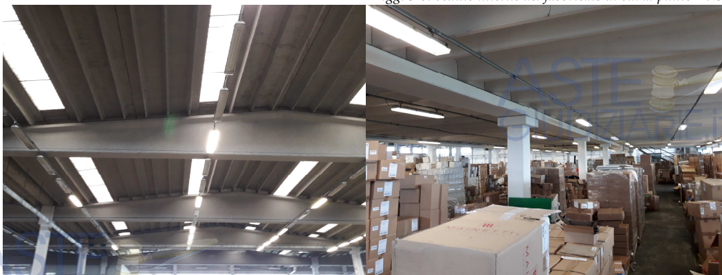
Figg. 7-8: vedute interne del fabbricato di cui al punto A: zona produttiva
