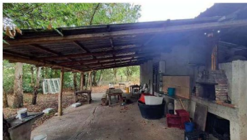
Foto 13: Catasto Terreni di Cittanova, foglio 60, particella 12 – La parte destinata a tettoia, realizzata con pali di legno e copertura di lumiere metalliche, misura circa metri 5,10 per metri 10,10.
