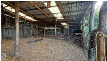
Foto 5: Catasto Terreni di Cittanova, foglio 60, particella 12 - Interno del fabbricato contrassegnato con la lettera "b".
