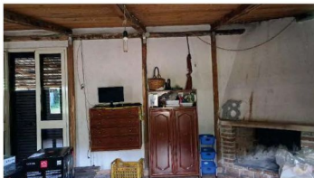
Foto 14: Catasto Terreni di Cittanova, foglio 60, particella 12 – Interno del fabbricato contrassegnato con la lettera "e".
