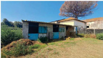
Foto 13: Catasto Terreni di Gioia Tauro, foglio 28, particella 61 – Fabbricato “e” - stalla, realizzata con struttura in muratura ordinaria con pareti in blocchi di calcestruzzo non intonacati. Il tetto, ad una falda inclinata, è stato realizzato con struttura di ferro ricoperta con lamiera grecate di metallo.
