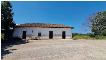
Foto 13: Catasto Terreni di Taurianova, foglio 18, particelle 12 e 13 – Fabbricato “d” – manufatto in muratura ordinaria e con tetto a falde inclinate, realizzato con struttura di legno e copertura di tegole, destinato ad abitazione.
