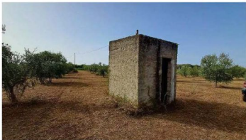
Foto 15: Catasto Terreni di Gioia Tauro, foglio 28, particella 61 – Fabbricato "F" - deposito. Realizzato con struttura in muratura ordinaria presenta pareti in blocchi di calcestruzzo intonacati al rustico e copertura piana.
