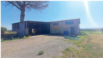
Foto 11: Catasto Terreni di Gioia Tauro, foglio 28, particella 61 – Il fabbricato "d", si compone di un capannone destinato ad officina con annessa tettoia.
