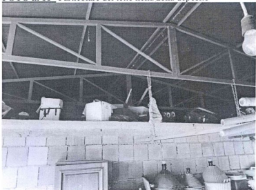
FOTO n. 11 Particolare del tetto nella zona deposito
