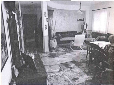
FOTO n. 7 Interni al pian terreno
