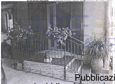
FOTO n. 22 Particolari dell'ingresso di servizio
