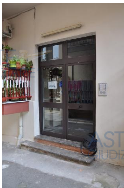
Foto 4 - Ingresso all'immobile dalla via Sant'Isidoro n. 39/A
