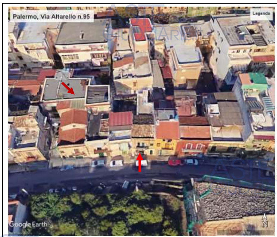
Fig. 1.1: Foto satellitare estratta da Google Earth. La freccia rossa individua l'edificio
