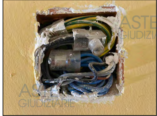
Interno di una cassetta di derivazione
