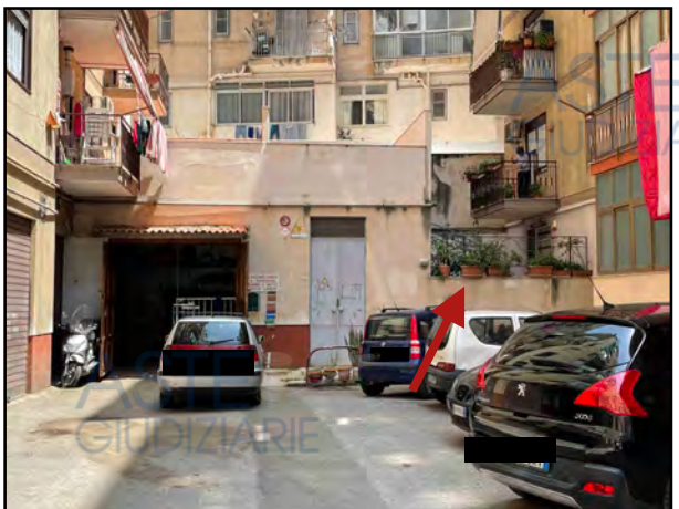
Terrazzo sul fronte principale-vista strada
