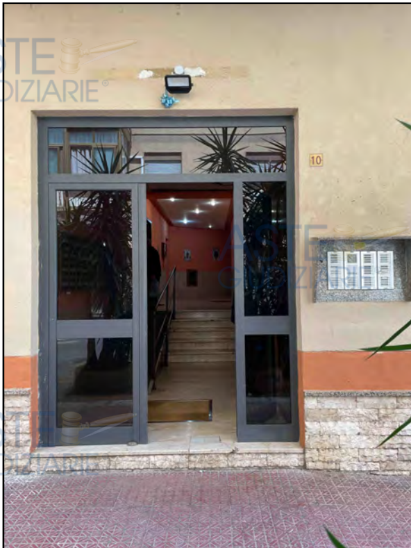
Portone di accesso al fabbricato civ.10
