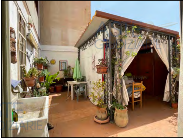
Tettoia sul retrospetto
