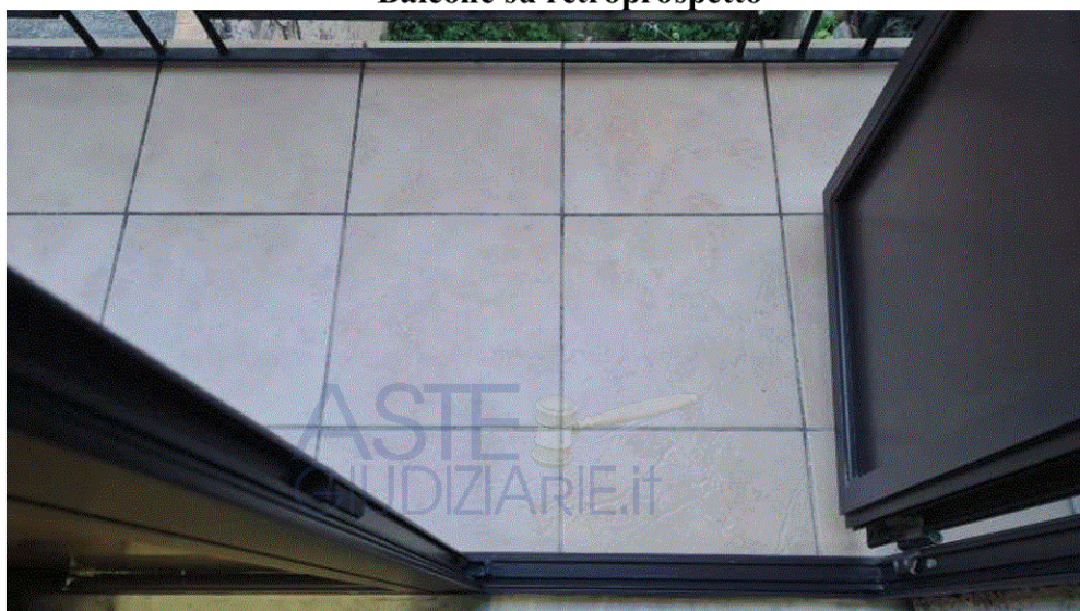
Balcone su retrospetto – Pavimento in gres porcellanato
