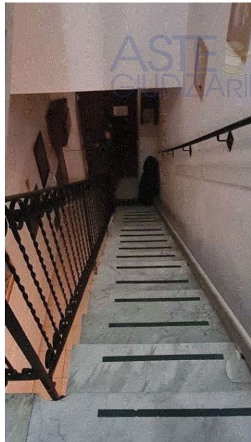
Androne e corpo scala condominiali
