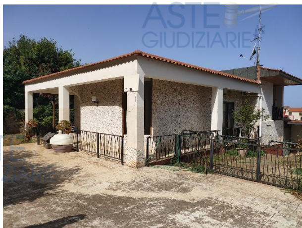
Esterno dall'ingresso angolo Est-Nord
