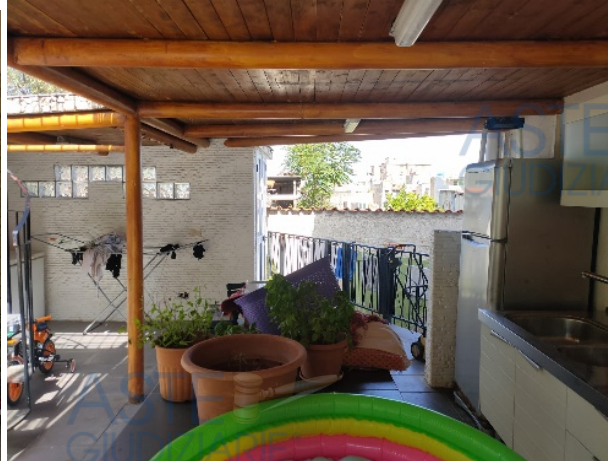
particolare verso il muro di confine ad ovest
