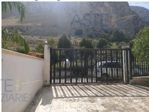
Lato monte (Est) cancello elettrico
