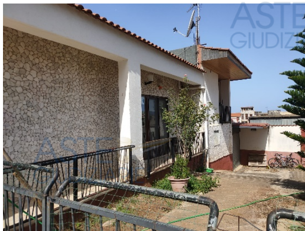
Esterno lato Nord
