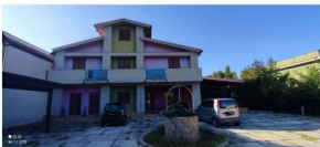
Foto -15- Prospetto principale
