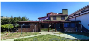
Foto -16- Prospetto posteriore, in primo piano il portico chiuso al piano terra
