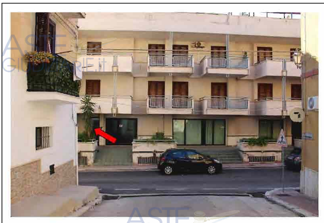
Foto dell'edificio – Individuazione del locale di deposito
