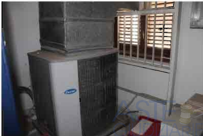
Vista del locale tecnica (UTA)
