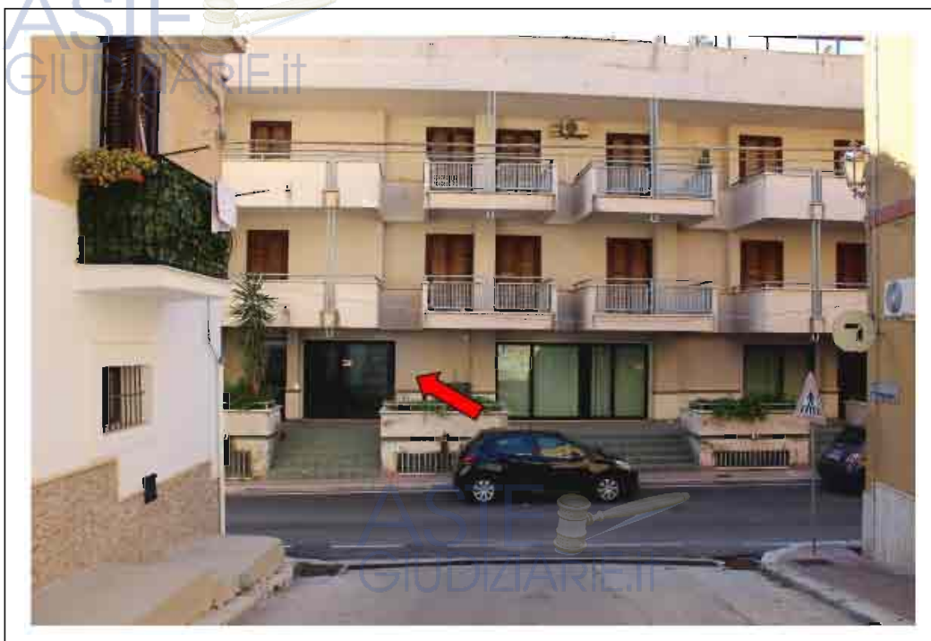
Foto dell'edificio – Individuazione dell'ingresso al locale adibito ad uffici
