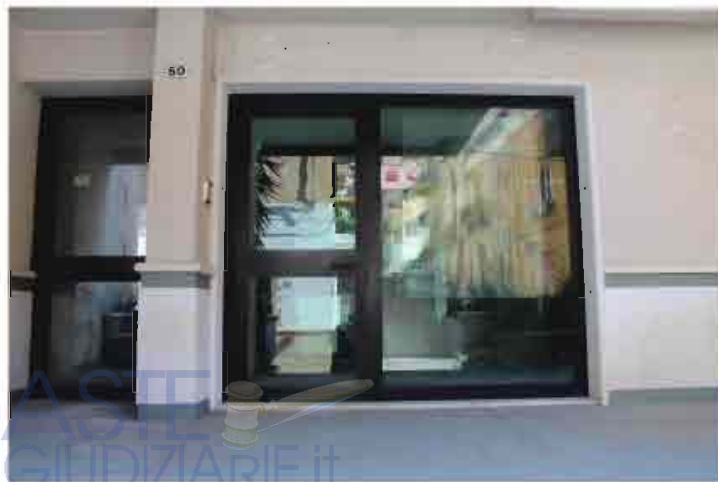
Vista dell'ingresso su corte comune
