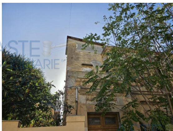
Foto n. 3 - particolare del prospetto principale
