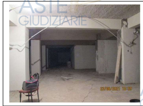
Fig. 49. Secondo piano scantinato. Corsia di manovra
