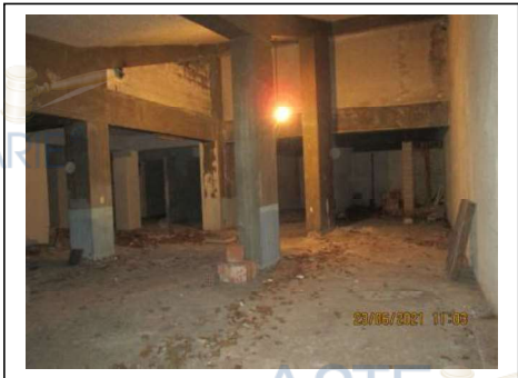
Fig. 42. Secondo piano scantinato. Zona sotto la rampa
