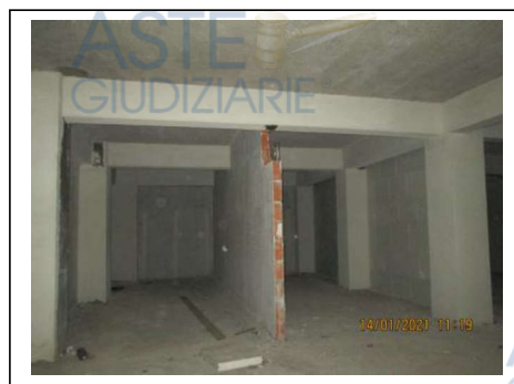
Fig. 35. Secondo piano scantinato. Box auto attigui al box antistante la rampa di accesso
