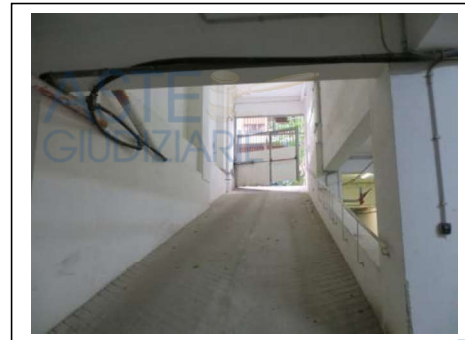
Fig. 13. Rampa del primo piano scantinato con ingresso dal civico n. 38 di via Villa Heloise
