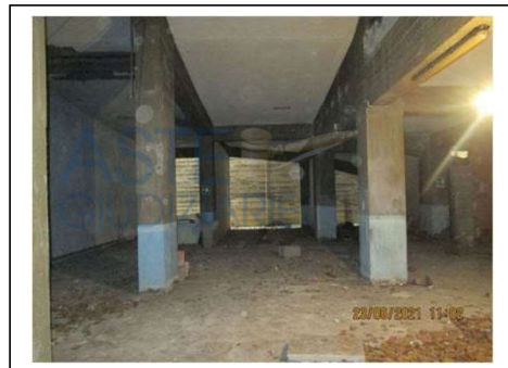
Fig. 45. Secondo piano scantinato. Zona sotto la rampa
