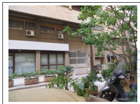
Fig. 7. La via Villa Heloise. Prospetto dell'edificio B dove sono ubicati gli accessi delle rampe del primo e secondo piano scantinato
