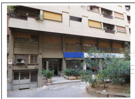
Fig. 6. La via Villa Heloise. Prospetto dell'edificio B dove sono ubicati gli accessi delle rampe del primo e secondo piano scantinato
