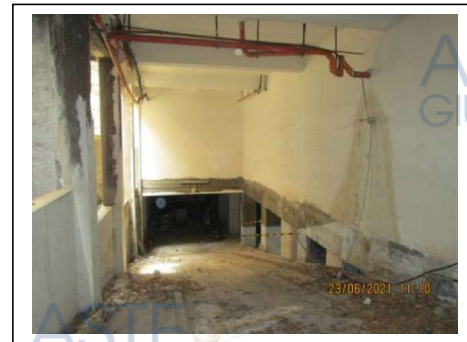
Fig.25. Rampa del secondo piano scantinato con ingresso dal civico n. 20 di via Villa Heloise
