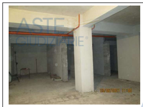
Fig. 37. Secondo piano scantinato, corsia di transito
