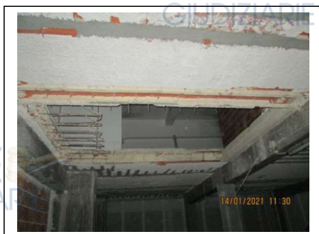
Fig. 54. Secondo piano scantinato. Zona nord-est. Foro su solaio di interpiano
