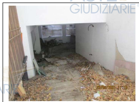
Fig.22. Rampa del secondo piano scantinato con ingresso dal civico n. 20 di via Villa Heloise
