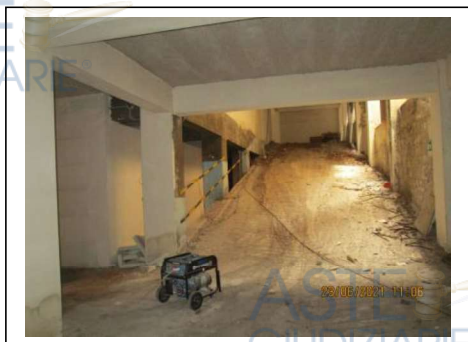
Fig.26. Rampa del secondo piano scantinato con ingresso dal civico n. 20 di via Villa Heloise
