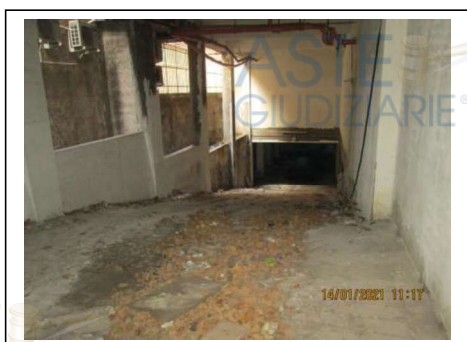
Fig.24. Rampa del secondo piano scantinato con ingresso dal civico n. 20 di via Villa Heloise
