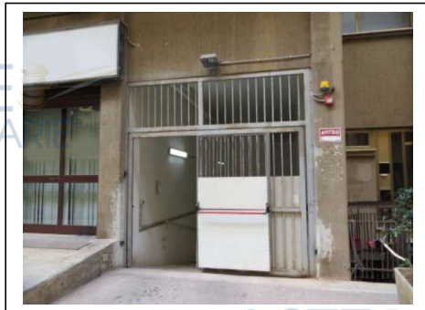
Fig. 12. Ingresso alla rampa del primo piano scantinato dal civico n. 38 di via Villa Heloise
