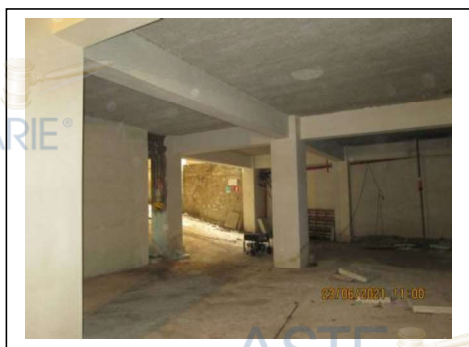
Fig. 36. Secondo piano scantinato, corsia di transito
