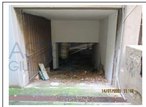
Fig.21. Rampa del secondo piano scantinato con ingresso dal civico n. 20 di via Villa Heloise
