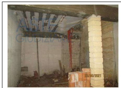
Fig. 51. Secondo piano scantinato. Soffitti ammalorati ripristinati con interventi di risanamento dell'intradosso
