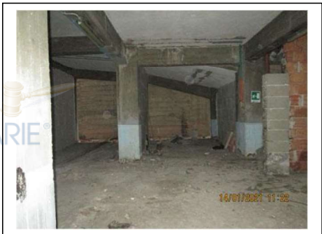
Fig. 44. Secondo piano scantinato. Zona sotto la rampa
