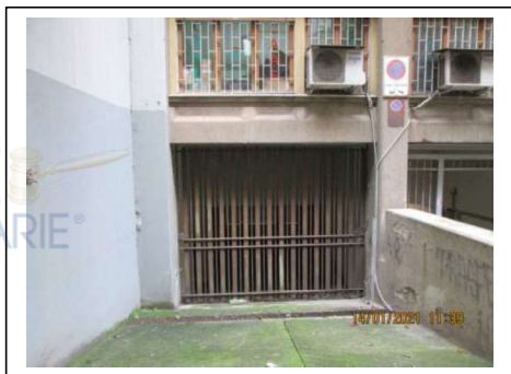
Fig.20. Ingresso alla rampa del secondo piano scantinato dal civico n. 20 di via Villa Heloise
