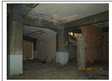
Fig. 43. Secondo piano scantinato. Zona sotto la rampa
