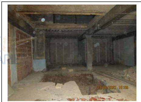
Fig. 52. Secondo piano scantinato. Zona nord-est
