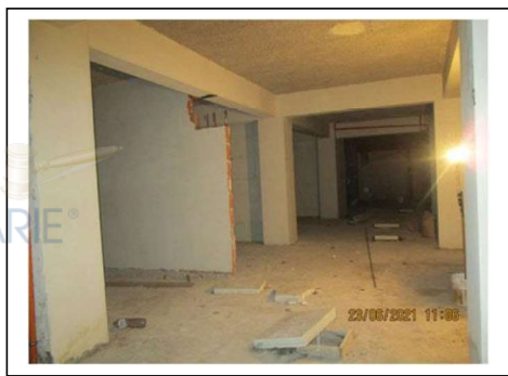
Fig. 38. Secondo piano scantinato, corsia di transito
