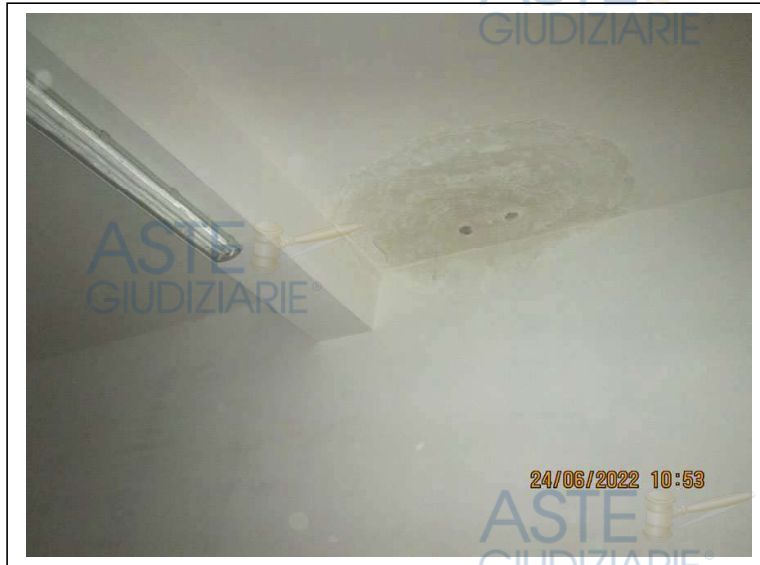
Foto 9. Box sub. 35. Degradì sulla porzione di soffitto più vicina all'ingresso
