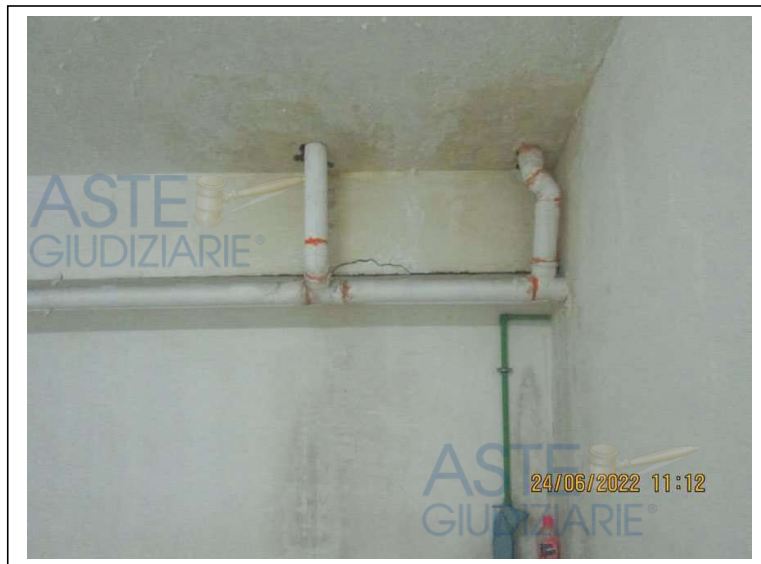
Foto 13-14. Box sub. 39. Degradati sulla trave della parete di fondo e sul soffitto in corrispondenza di tubazioni
