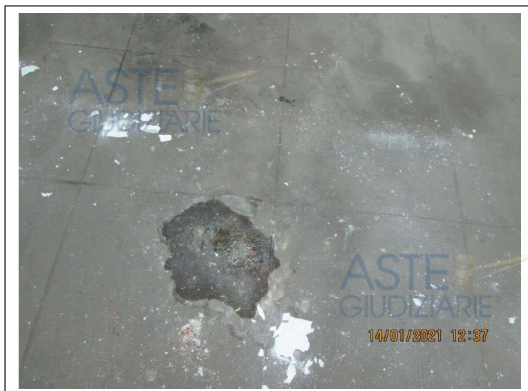
Foto 6. Box sub. 32. Chiazza di acqua sul pavimento conseguenza del gocciolamento del soffitto
