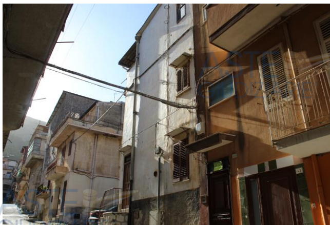
Vista del fabbricato da via Anime Sante
