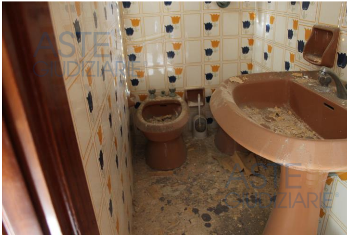
Vista del wc (P1°)
