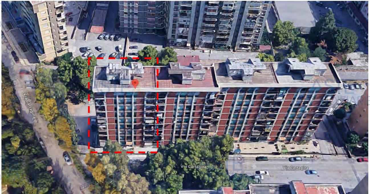
Figura 3. Vista 3d tratta da google maps - Prospetto Sud del fabbricato in condominio
