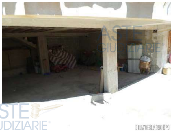
Foto 1: Piano seminterrato porzione area parcheggio
