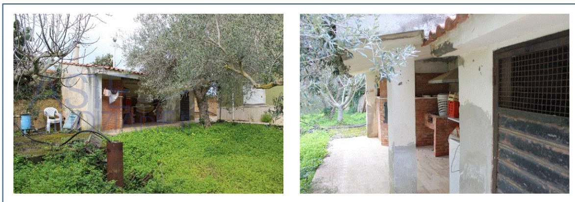
Foto dell'area pavimentata parzialmente coperta (allegato 2-1)
