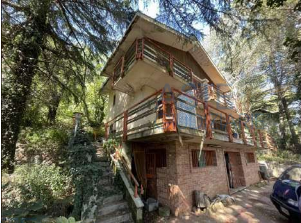
Esterni: una delle scale di accesso al piano primo
