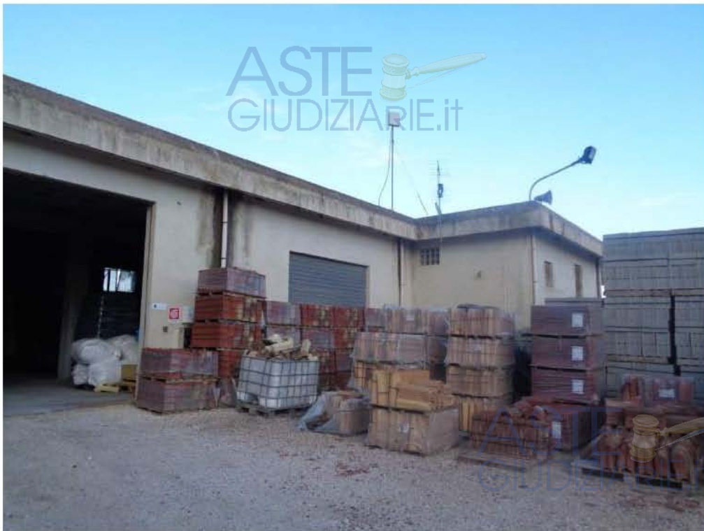
Prospetto parziale sul piazzale interno corpo 5
