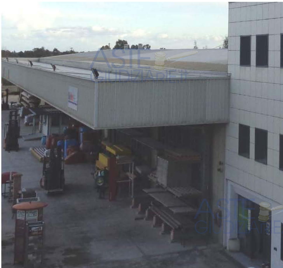
Particolare copertura del corpo 3 e lato in aderenza al corpo 2
