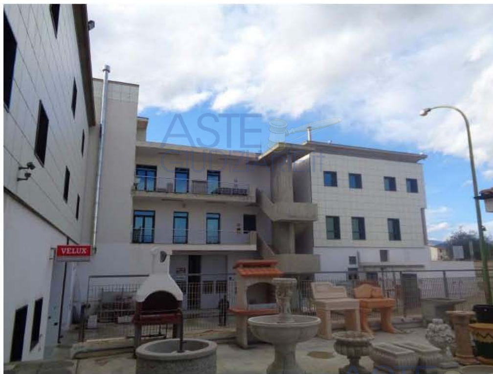
Prospetto verso piazzale interno
