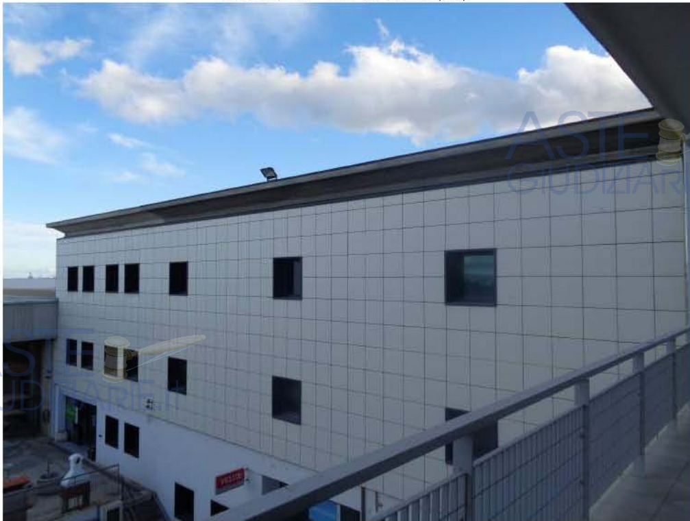
Prospetto verso piazzale interno
