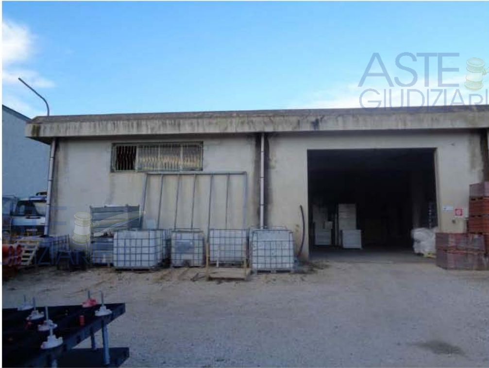
Prospetto parziale sul piazzale interno corpo 5
