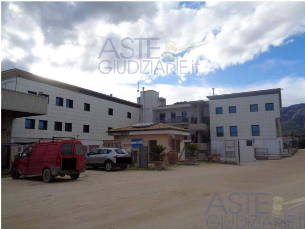
Prospetto verso piazzale interno
