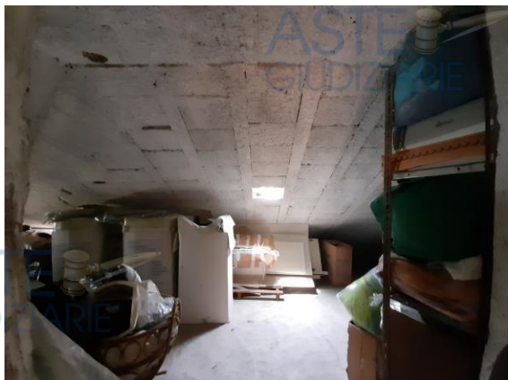
3. Interno del locale sottotetto
