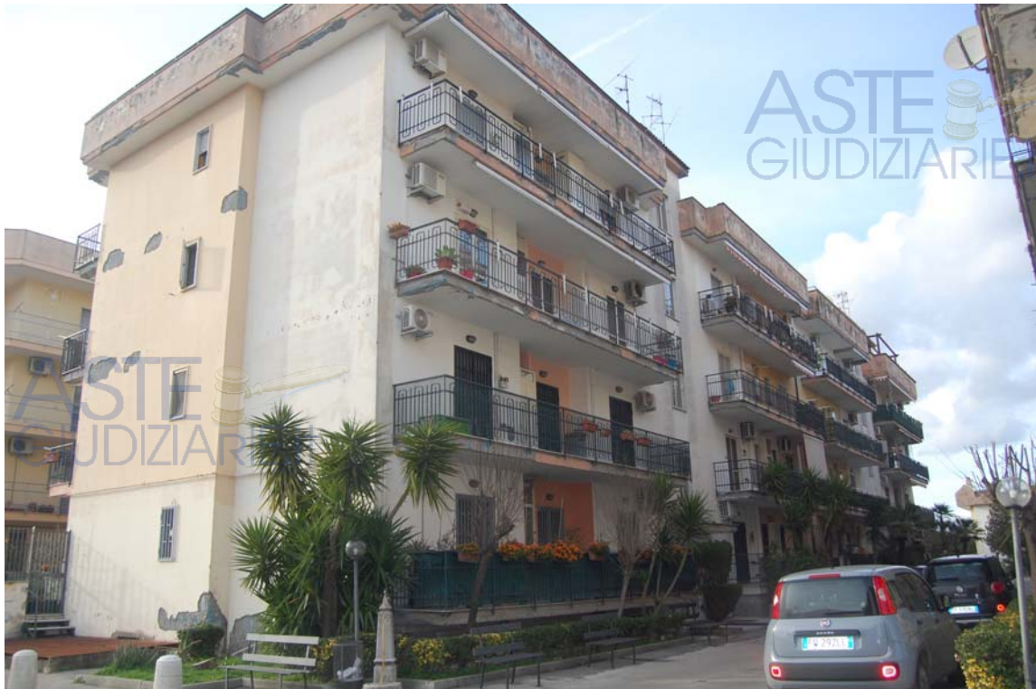
Foto edificio B scala A.
