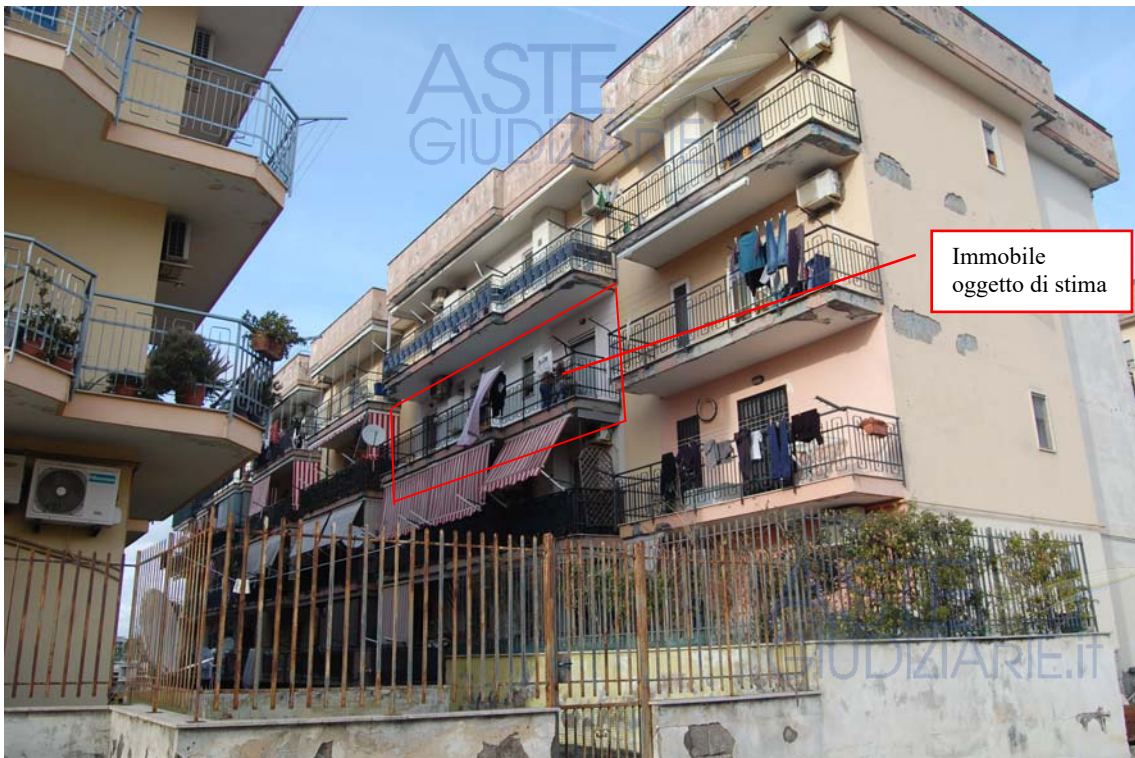
Foto edificio B scala A.
