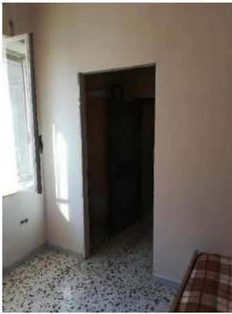
FOTO A- vano porta nel muro a confine
