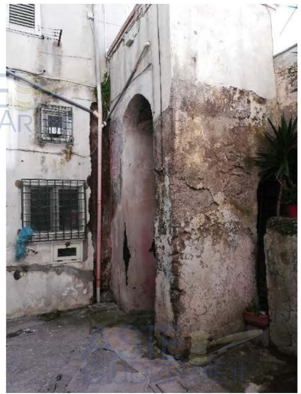
VISTA della p.lla 2070 sub 3 (CANTINA)
