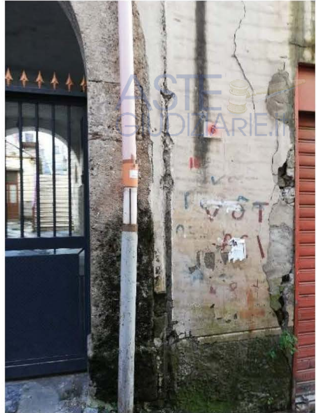
VISTA del cancello di ingresso al cortile interno
