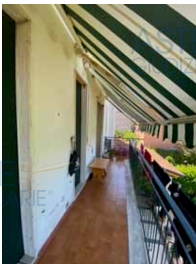
Foto n. 19: Balcone fronte ovest
