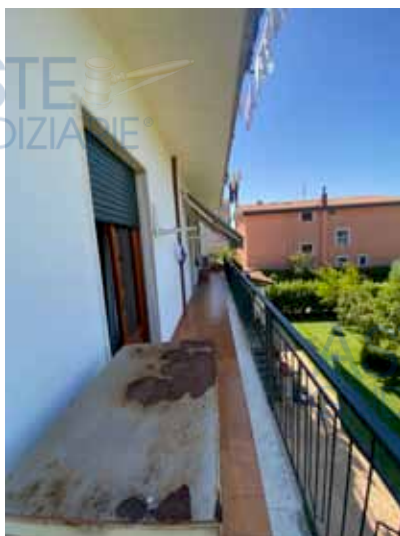
Foto n. 18: Balcone fronte ovest
