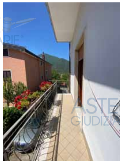
Foto n. 20: Balcone fronte sud (solo parzialmente afferente al bene pignorato)
