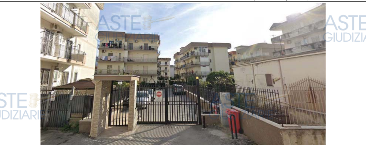
Vista d'insieme del contesto condominiale "Parco Aurora" in cui risiedono i cespiti di cui al Lotto Unico. Le parti condominiali risultano recintate e munite di cancello pedonale e carrabile.
