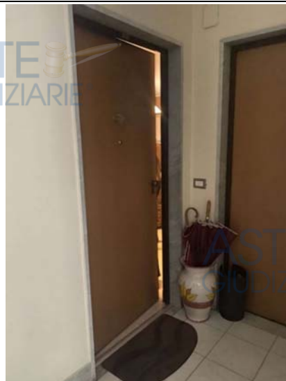
Foto 15: Particolare porta di accesso abitazione Sub. 5
