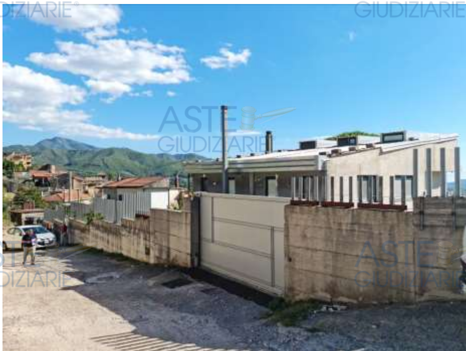
Cancello d'ingresso carrabile e pedonale, lato nord.
