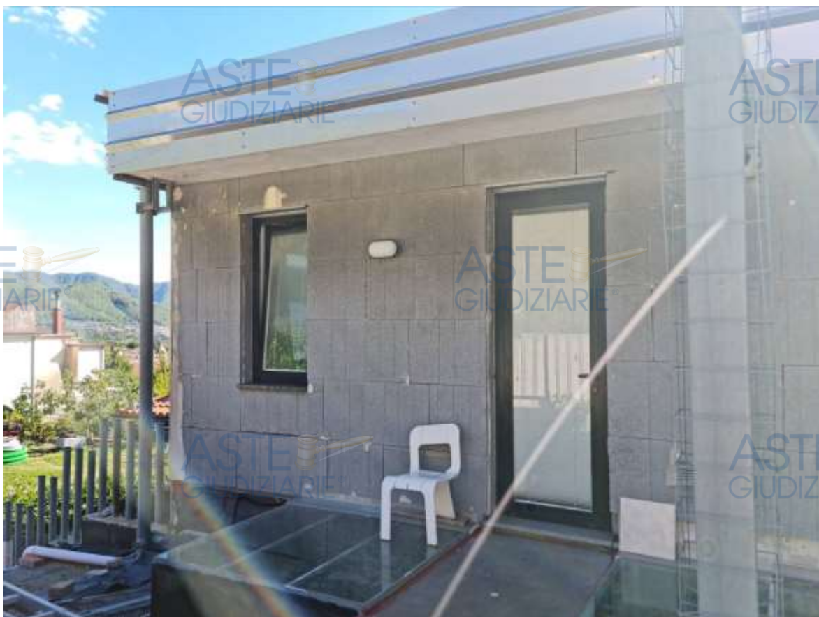
Veduta dell'attuale accesso esterno all'appartamento in sub 15
