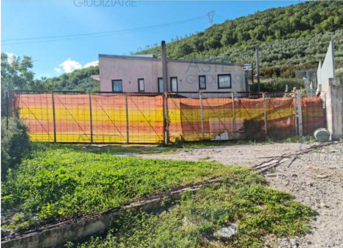
Cancello d'ingresso carrabile ad est, attualmente ancora cantierato.
