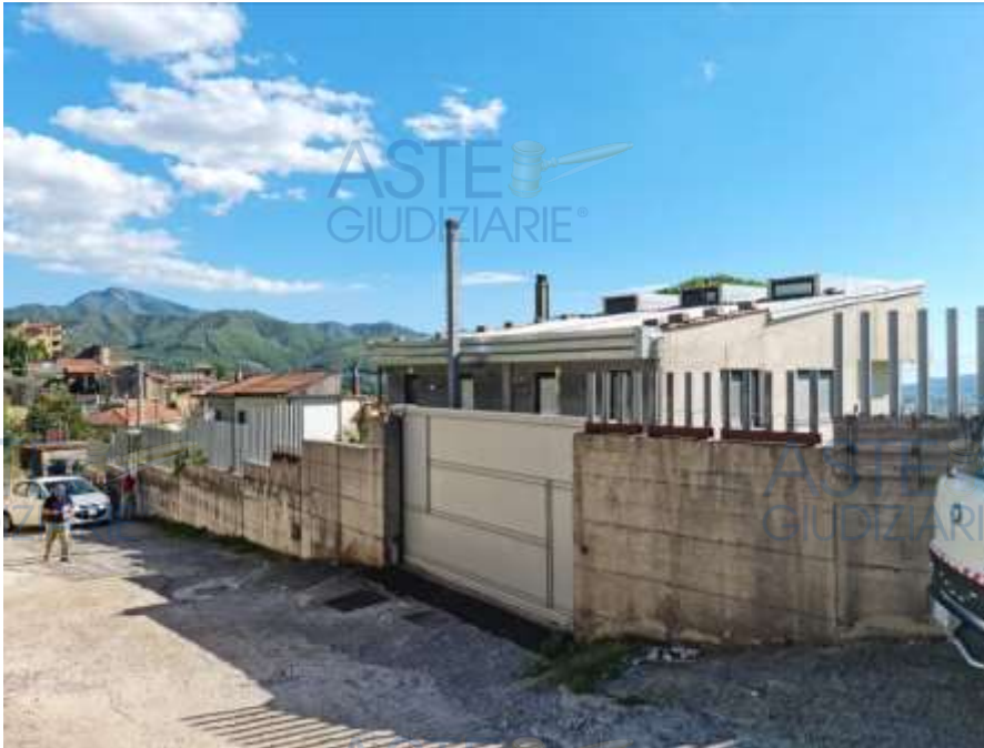
Cancello d'ingresso carrabile e pedonale, lato nord.
