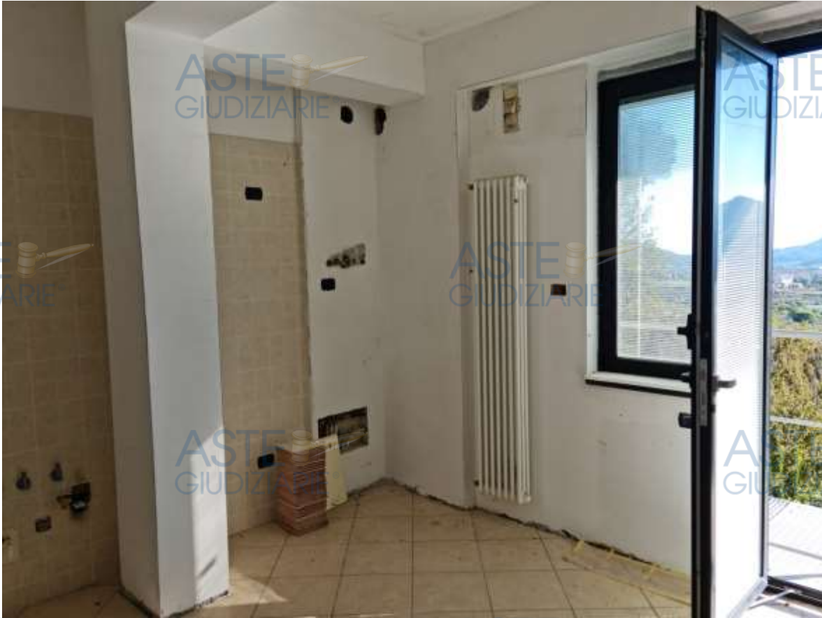
Veduta della cucina/soggiorno dell'appartamento in sub 16
