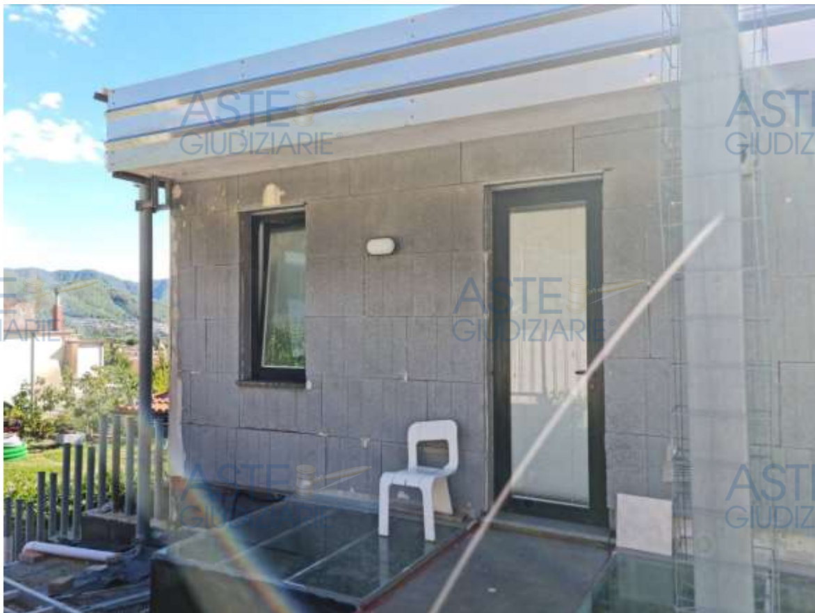
Veduta dell'attuale accesso esterno all'appartamento in sub 15
