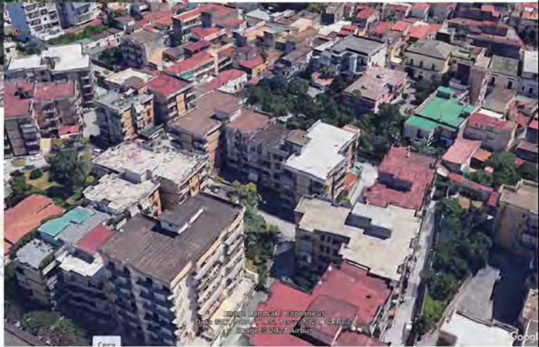
Inquadramento generale del fabbricato, con indicazione viabilità ed accesso - vista dall'alto
