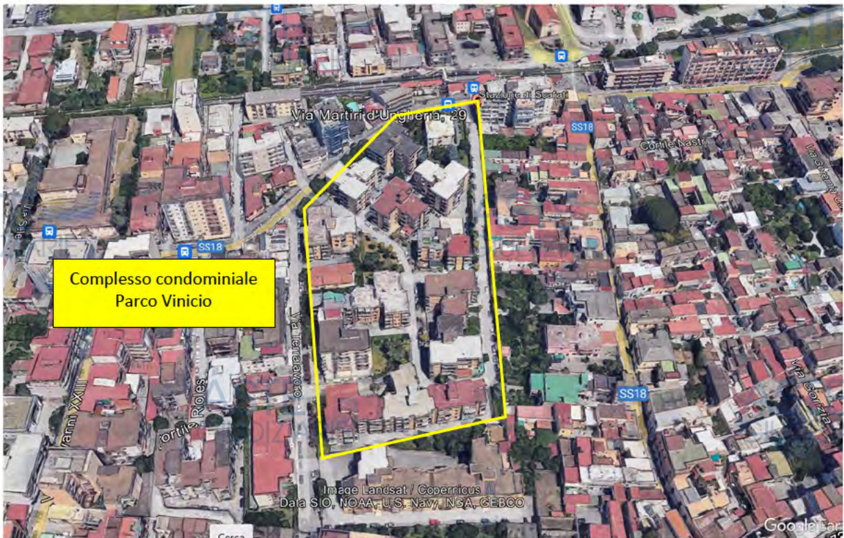
All.10 d) Ortofoto dettaglio del Lotto Unico, con indicazione del fabbricato condominiale in cui risiedono le unità immobiliari oggetto di pignoramento. (fonte: GoogleMaps);
