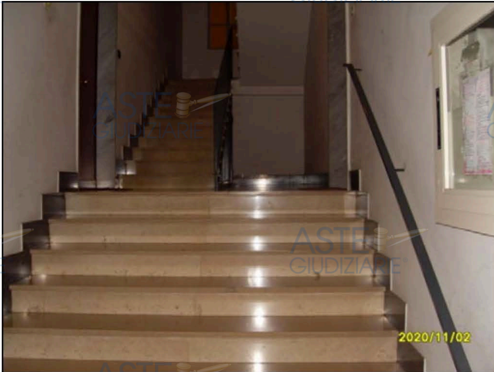
Foto 5. Particolare rampa di scala di accesso alle abitazioni
