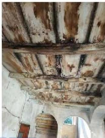
Non è stato possibile accedere ai locali al piano secondo in quanto la struttura del solaio balcone/portico di accesso al piano e la struttura della copertura risultano essere in evidente stato di degrado e non garantiscono la necessaria sicurezza per accedere al piano, per la valutazione della consistenza ci si baserà sulle misure dei locali sottostanti.
