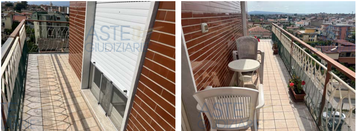
Dettagli del balcone su via Brindisi
